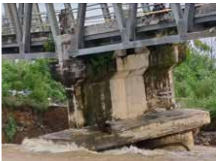
Gambar 1. Kemiringan pilar akibat gerusan pada jembatan Keumala (Zamahsari, 2023)
