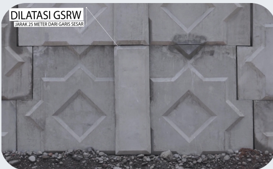
Gambar 11. Dinding Penahan Tanah dengan Dilatasi
