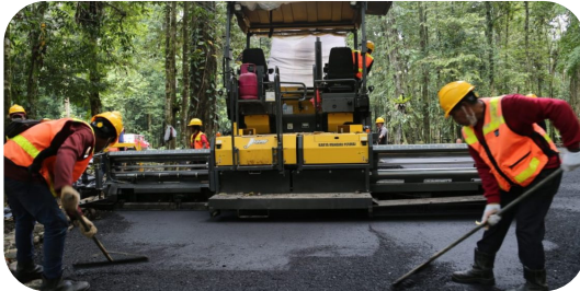
Gambar 9. Tailing untuk Bahan Jalan Sumber: Freeport Manfaatkan Tailing sebagai Bahan Campuran Aspal - TopBusiness
