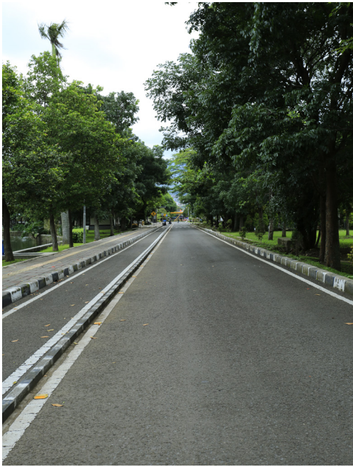
Gambar 3. fly ash untuk beton tanpa semen (trotoar dan kerb jalan) Pusjatan 2016
