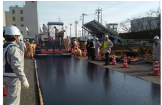
Gambar 9. Uji Coba Lapis Gussasphalt Asbuton di Atas Dek Baja di Tsukuba Jepang Tahun 2016
