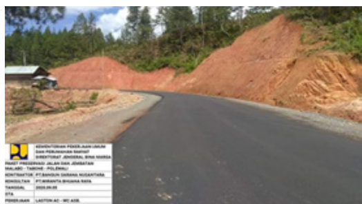
Gambar 5. Perkerasan Jalan Hot Mix Asbuton B 50/30 di Sulawesi Tenggara
