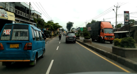
Gambar 6. ACWC-RAP Daerah Purwasari Ruas Jalan Pantura Karawang-Cikampek
