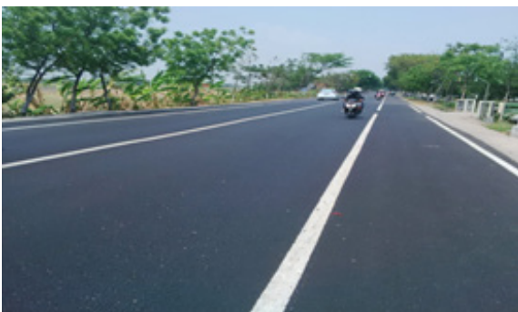
Gambar8. Perkerasan Jalan Hot Mix Asbuton Pra-Campur di Caruban Jawa Timur Tahun 2013
