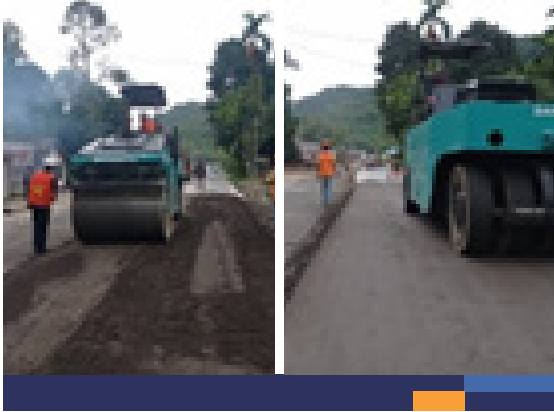
Gambar 6. Proses Pemadatan
