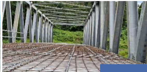
Sumber: Bahan Monitoring PPK 5.2 Gambar 4. Foto Gelagar Jembatan
