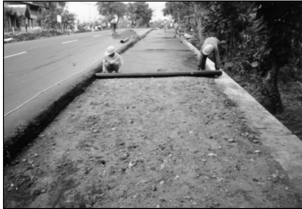
Gambar 25 Membran geosintetik
