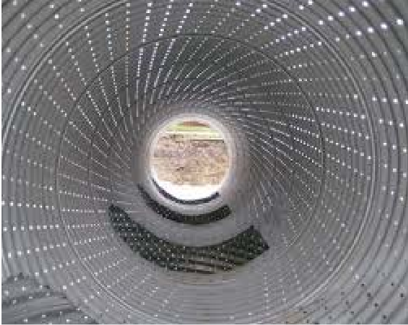
Gambar C.5 - Pipa baja bergelombang dengan Pervorasi
