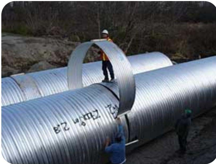
Gambar C.6 - Pipa baja bergelombang dengan pelat penyambung
