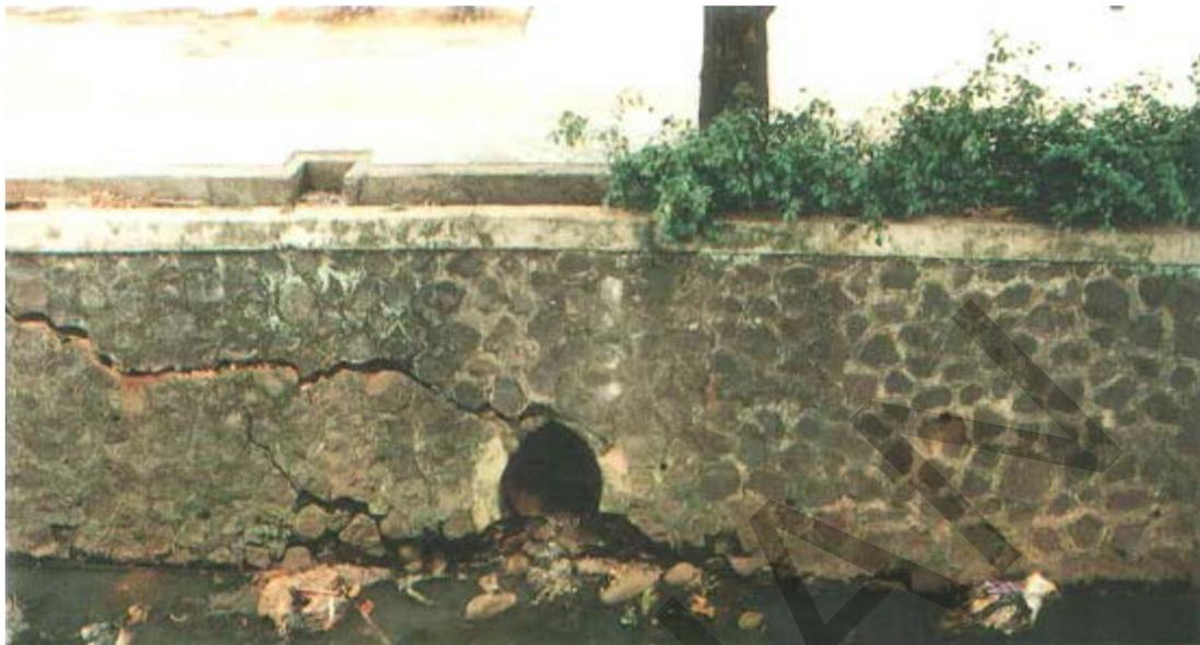
**Gambar 50. Ambblas Pada Lereng Dengan Pasangan Batu.**
