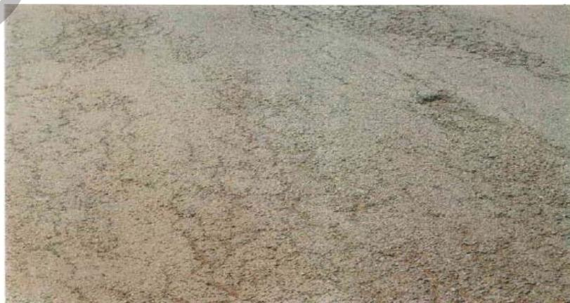
Gambar 11. Kerusakan Retak Buaya Pada Permukaan Jalan Beraspal
