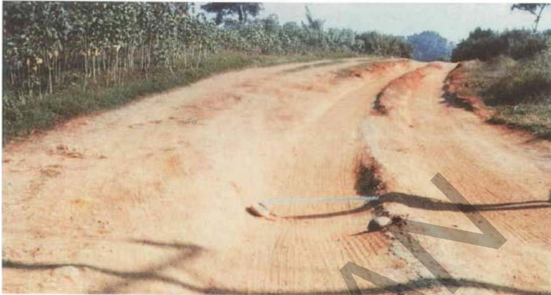
**Gambar 6. Kerusakan Alur Pada Permukaan Jalan Tidak Beraspal**
