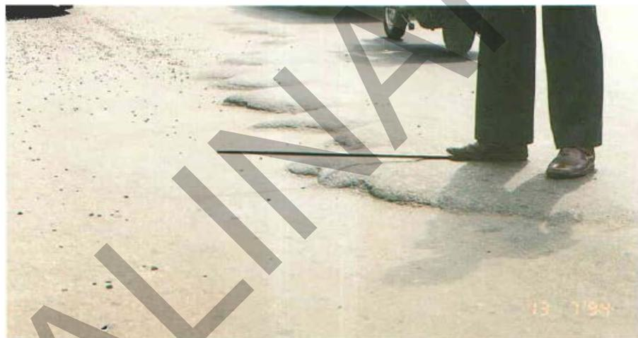
**Gambar 9. Kerusakan Jembul Pada Permukaan Jalan Beraspal**
