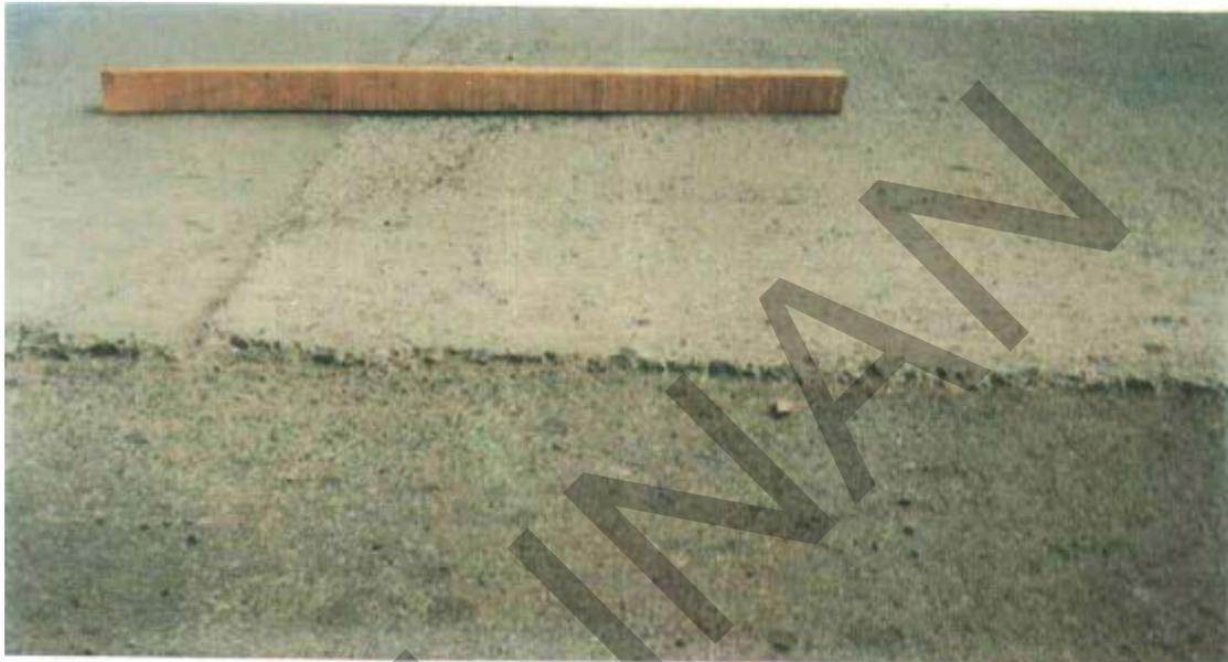
**Gambar 17. Penurunan Slab Pada Sambungan Perkerasan Kaku**
