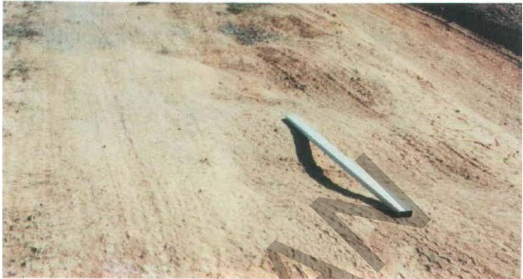
**Gambar 4. Kerusakan Bergelombang/Keriting Pada Permukaan Jalan Tidak Beraspal**
