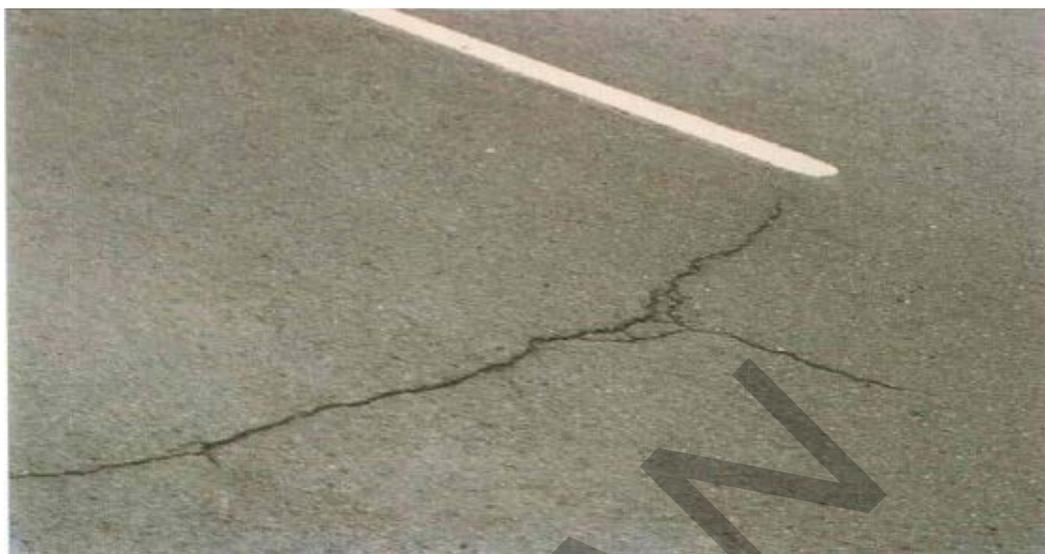
**Gambar 12. Kerusakan Retak Garis Pada Permukaan Jalan Beraspal**
