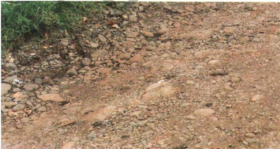
**Gambar 15. Permukaan yang Tergerus Pada Permukaan Jalan Tidak Beraspal**
