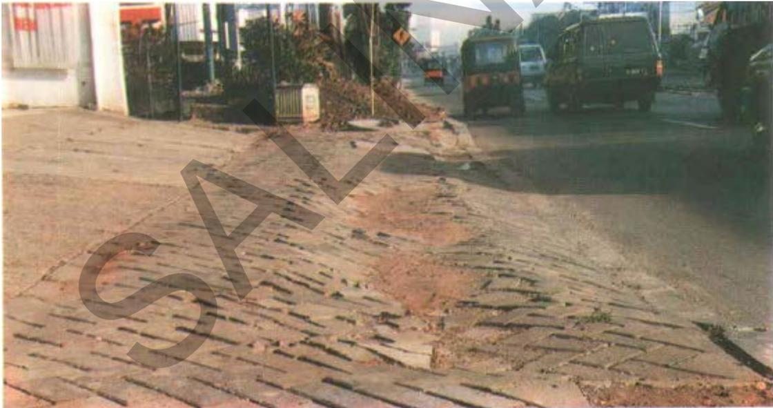
Gambar 24. Perbedaan Ketinggian Pada Trotoar dari Blok Terkunci
