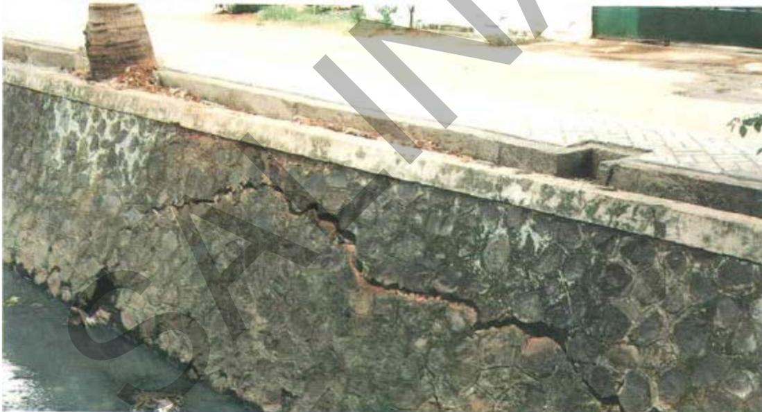
**Gambar 49. Retak Pada Lereng Dengan Pasangan Batu.**
