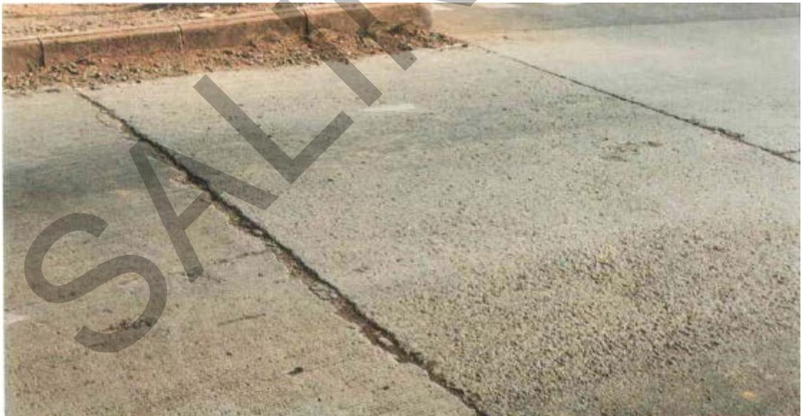
**Gambar 18. Slab Pecah/Mengelupas Pada Sambungan Perkerasan Kaku**
