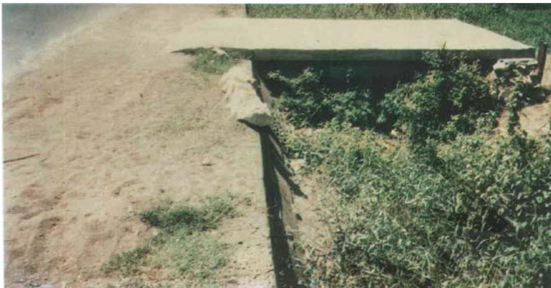
**Gambar 20. Permukaan Lepas Pada Perkerasan Jalan Tidak Beraspal**
