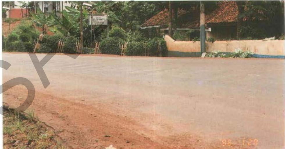
**Gambar 3. Kerusakan Bergelombang/Keriting Pada Permukaan Jalan Beraspal**
