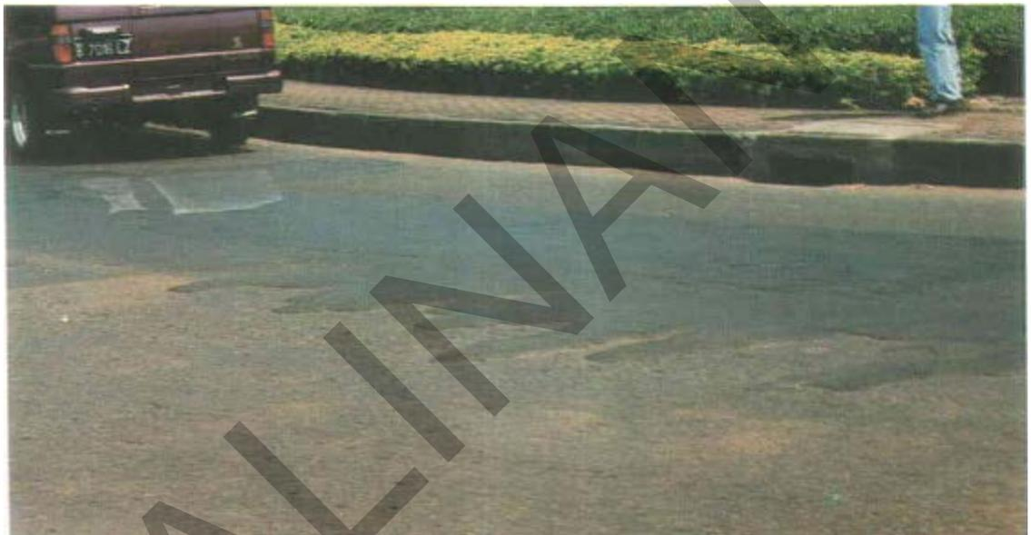
**Gambar 13. Kegemukan Aspal Pada Permukaan Jalan Beraspal**
