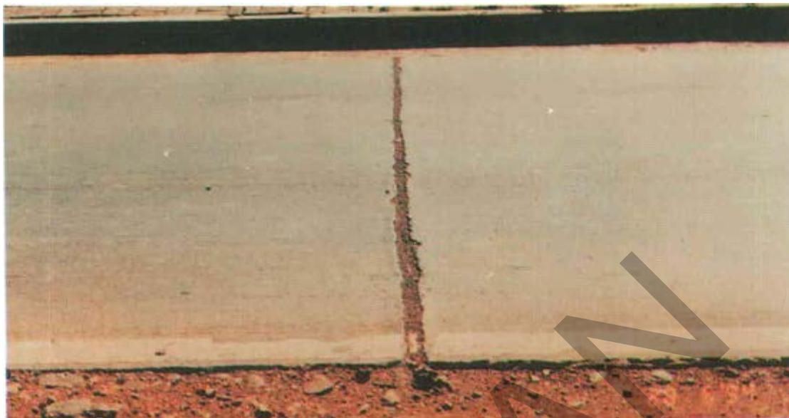
**Gambar 16. Kerusakan Pengisi Celah Sambungan Perkerasan Kaku**
