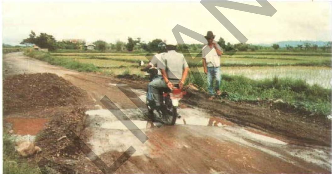
**Gambar 2. Kerusakan Lubang Pada Permukaan Jalan Tidak Beraspal**
