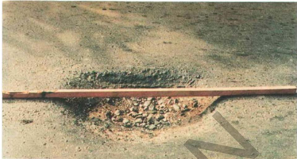
**Gambar 1. Kerusakan Lubang Pada Permukaan Jalan Beraspal.**
