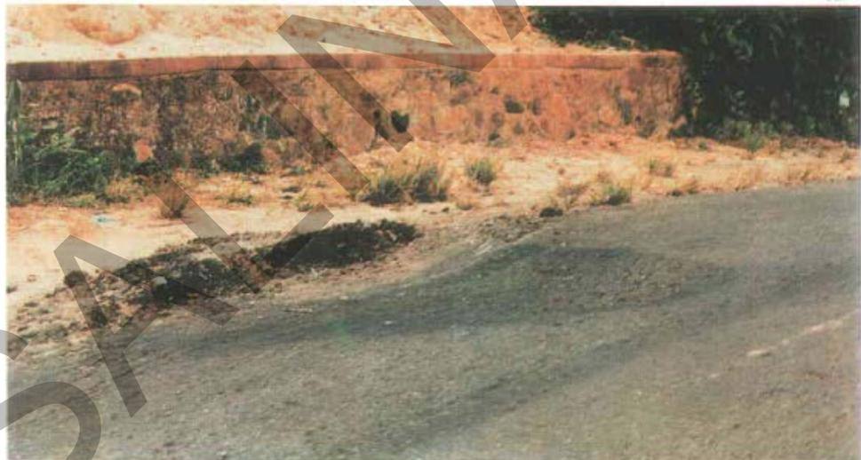
Gambar 7. Penurunan/Ambles Pada Permukaan Jalan Beraspal
