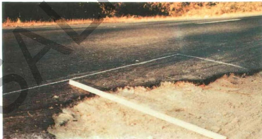
**Gambar 10. Kerusakan Tepi Pada Permukaan Jalan Beraspal**
