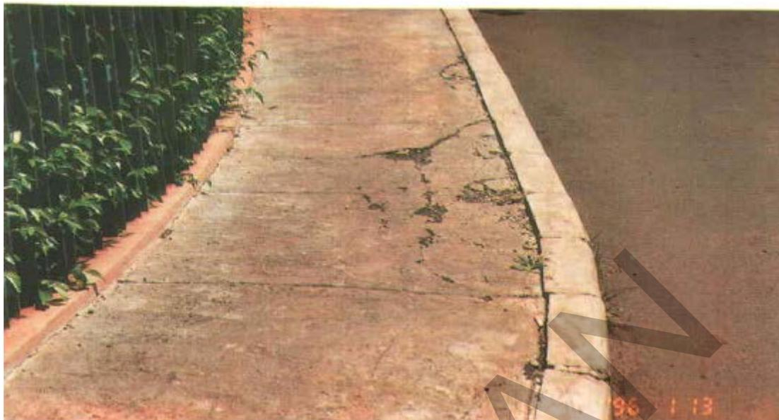
**Gambar 25. Kerusakan Beton Pecah/Mengelupas Pada Trotoar dari Beton**
