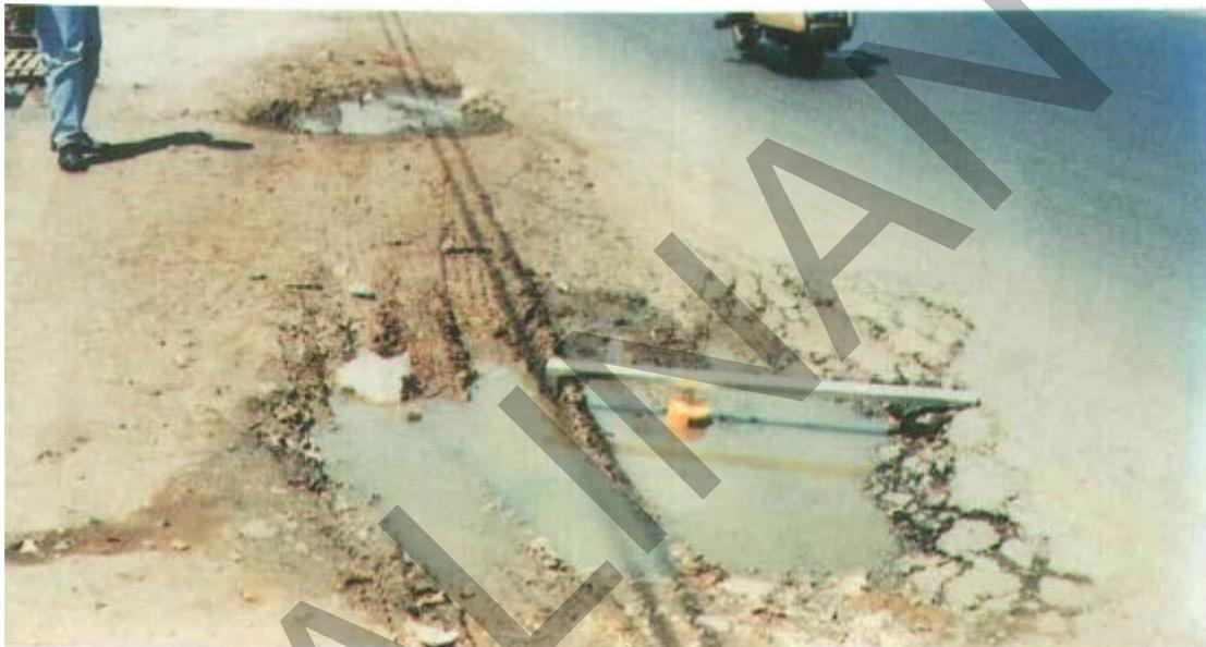
**Gambar 23. Lubang/Penurunan Pada Trotoar Tidak Beraspal**
