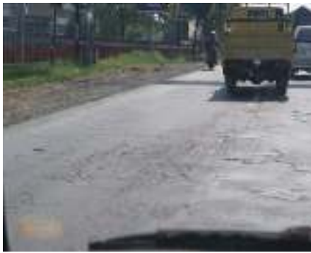
Gambar 6-15. Jalan Retak
