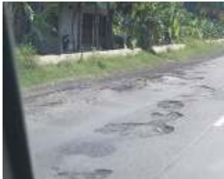
Gambar 6-14. Jalan Stripping
