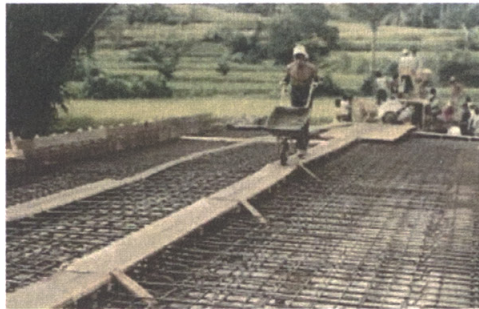
Gambar 13 - Mengangkut adukan beton di lokasi pengecoran
