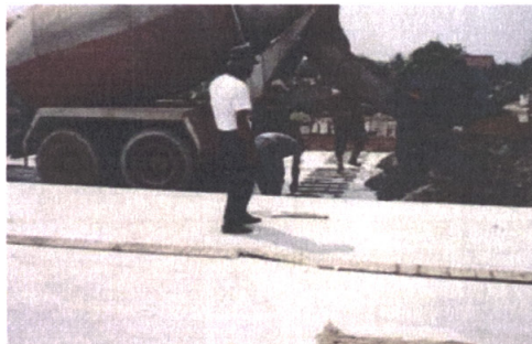
Gambar 14 - Adukan beton diangkut ke lokasi pengecoran dengan truck mixer
