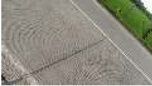
Gambar 7-b-2. Foto Perkerasan Beton Fiber Cor Di Tempat (M2) Umur 32 Bulan (September 2012)
