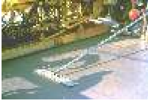
Gambar 28-aa. Penekanan alat pelepa ( Bull float )
