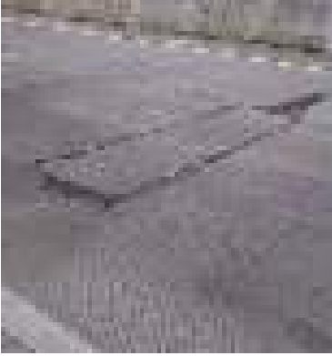
Gambar 19-a. Foto perbaikan full depth pada Base Panel
