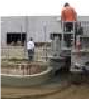
Gambar 28-c. Acuan bergerak untuk pagar pengaman
