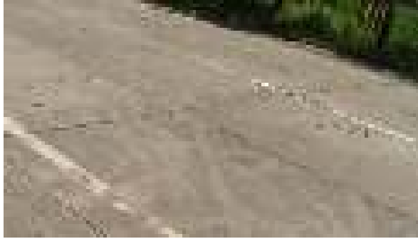
Gambar 7-a- 2 Foto Perkerasan Beton Pracetak Konvensional (M1) Umur 32 Bulan (September 2012)
