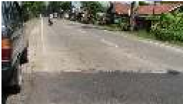
Gambar 7-f-1. Foto Perkerasan Beton Prategang Cor di Tempat (M6a) Umur 32 Bulan (September 2012)
