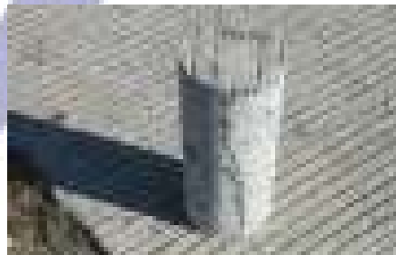
Gambar 17-d. Foto retak vertikal pada beton pracetak konvensional (M1) nomor 57 (Juni 2012)
