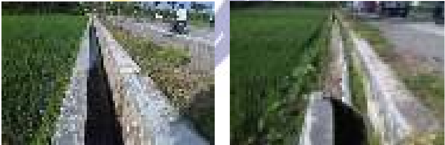
Gambar 15-2 Foto kondisi drainase umur 2 bulan (kiri) dan 1 tahun (kanan, rebah 32 m)
