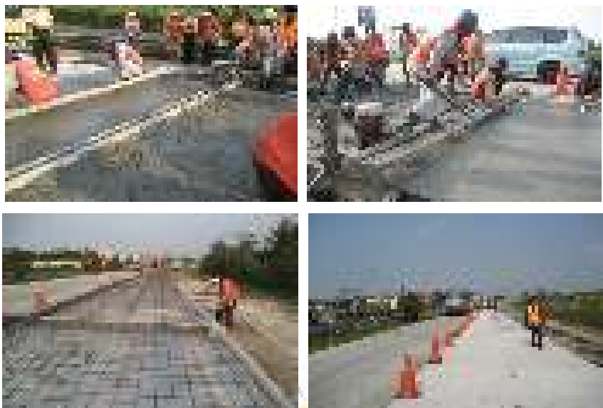
Gambar 27-m. Sistem acuan tetap pada pelaksanaan JRCP dan CRCP di Jalan Tol Tangerang-Merak
