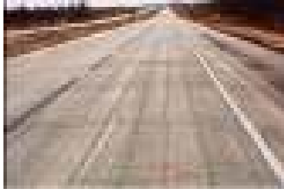
Gambar 28-u. Goresan vibrator yang tidak bekerja dengan benar.
