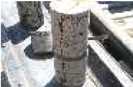
Gambar 17-c. Foto retak vertikal pada beton karet (M3) nomor 17 (Juni 2012)
