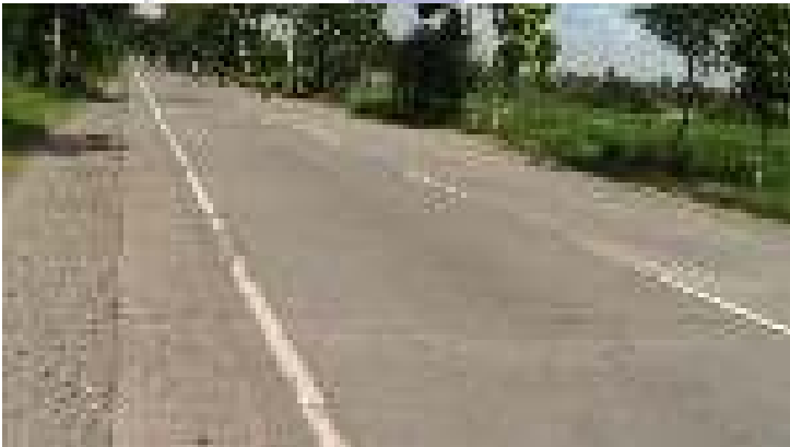
Gambar 7-e-1. Perkerasan Beton Cor di Tempat (M6b) Umur 32 Bulan (September 2012)
