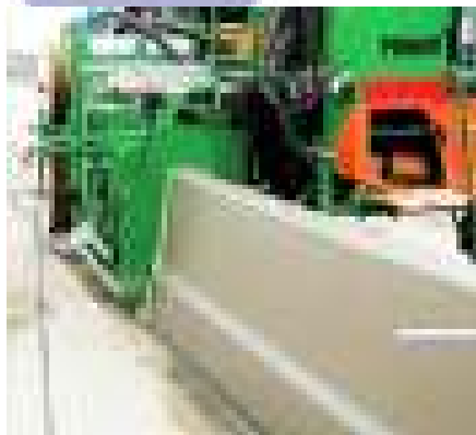
Gambar 28-e. Acuan bergerak untuk parapet
