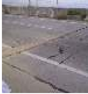
Gambar 19-b. Foto penutupan retak pada Joint Panel (JP)
