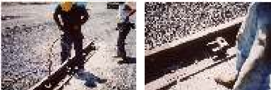
Gambar 27-c. Pemancangan Pin Menggunakan Jackhammer dan Pin yang Sudah Terpancang
