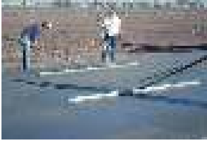
Gambar 28- bb. Straightedge Finishing
