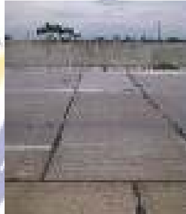
Gambar 19-d. Foto perbaikan Joint Panel dgn metode beton T terbalik
