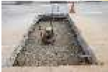
Gambar 23-f. Foto pemadatan Fondasi Granular
