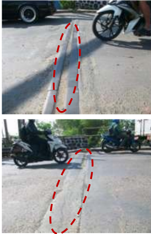
Gambar 5.2 Kondisi siar muai jembatan
