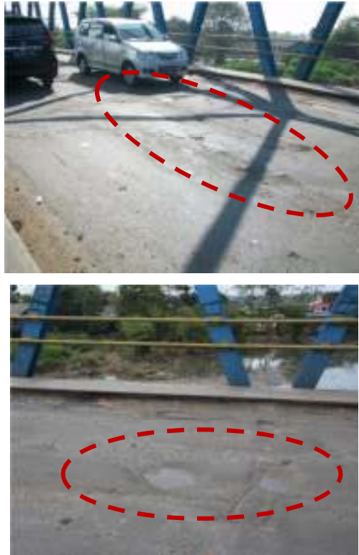
Gambar 5.5 Kondisi lapis permukaan
