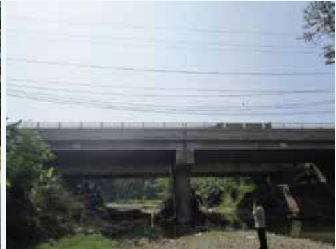
Gambar A.5 Tampak samping Jembatan Cilalawi-B
