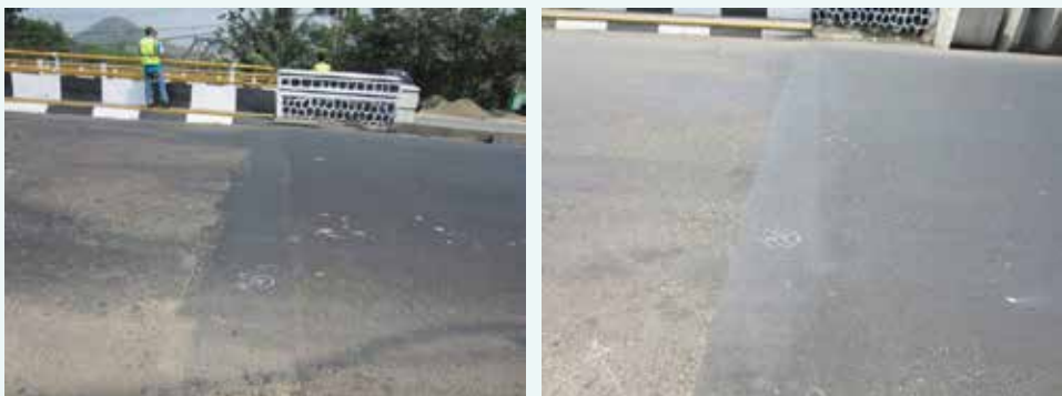
Gambar A.11 Sambungan Siar Muai
