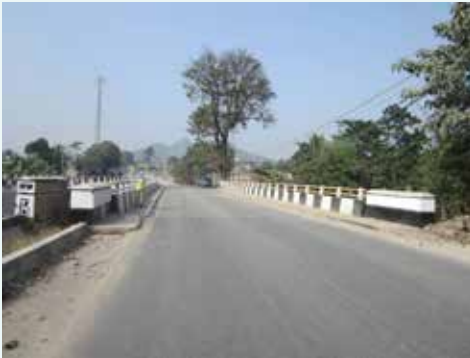
Gambar A.4 Tampak depan Jembatan Cilalawi-B
