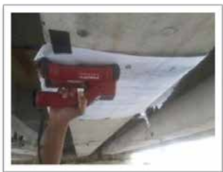
Gambar 4.9 Pengukuran ketebalan selimut beton
