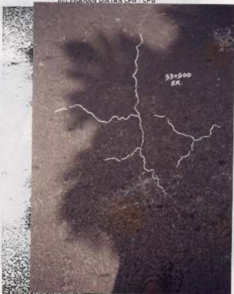
RETAK TAK BERATURAN KM. 33.900 ( R ) KE MOJOKERTO
