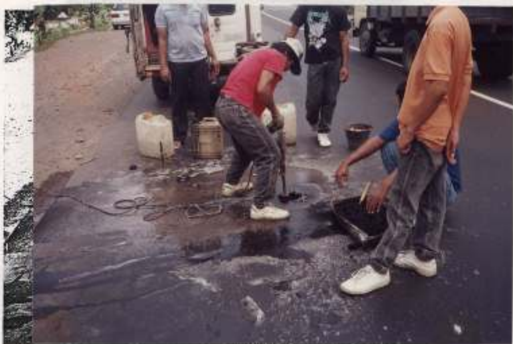
PEKERJAAN PENAMBALAN LOBANG HASIL PENGAMBILAN CONTOH INTI KM. 38.900 ( L ) KE MOJOKERTO PELEPERAN DIATAS LPA - LPS
