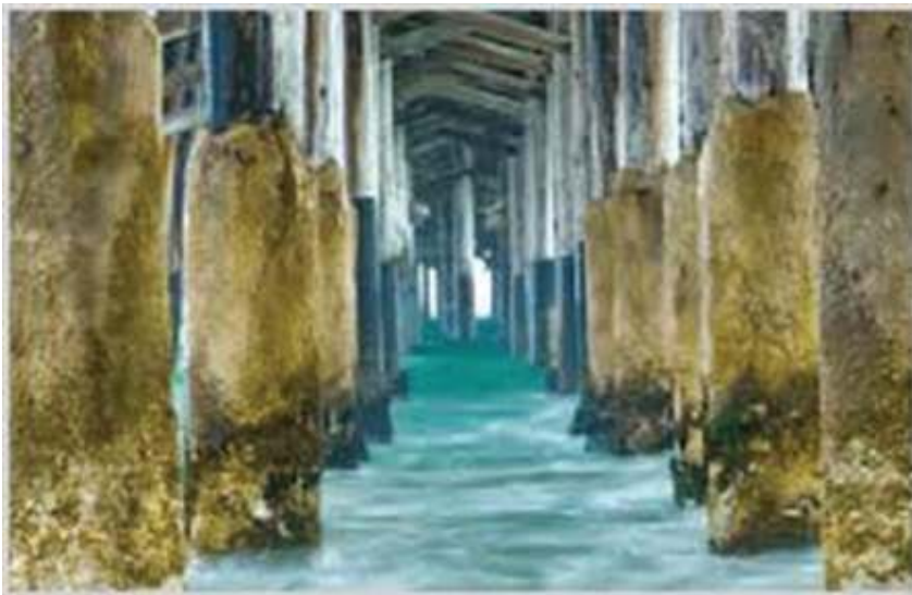
Gambar 3.3. Penempelan Biota Laut pada Tiang Pancang
