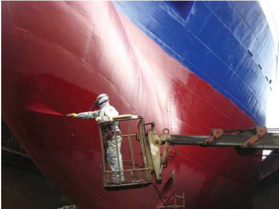
Gambar 4.1. Perlindungan Terhadap Biota Penempel Menggunakan Cat Antifouling
