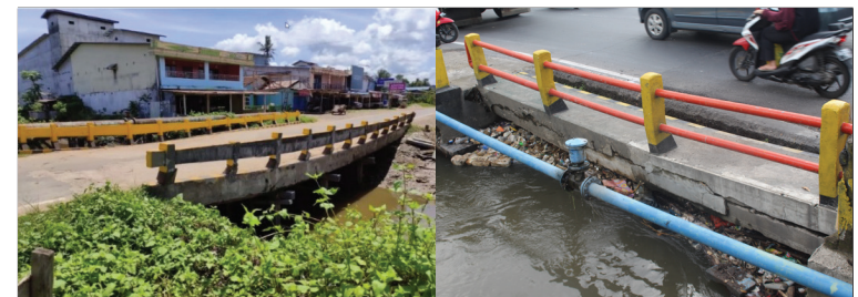
Gambar 46 Ilustrasi Kode Kerusakan 702 Lendutan yang berlebihan
