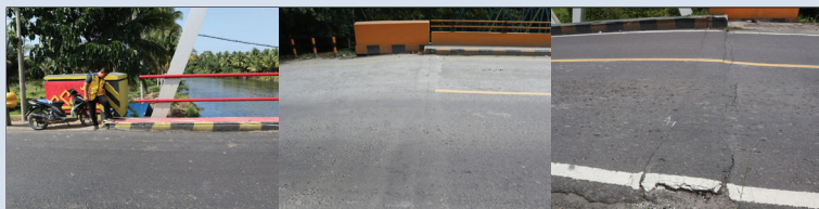
Gambar 55 Ilustrasi kode kerusakan 802 Kehilangan kemampuan bergerak
