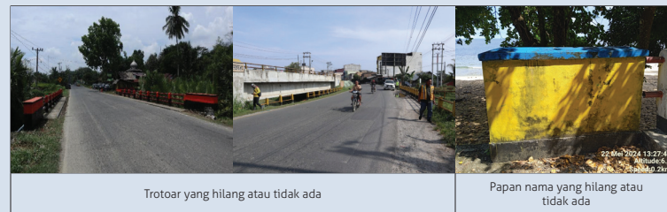
Gambar 67 Ilustrasi kode kerusakan 912 Bagian yang hilang atau tidak ada
