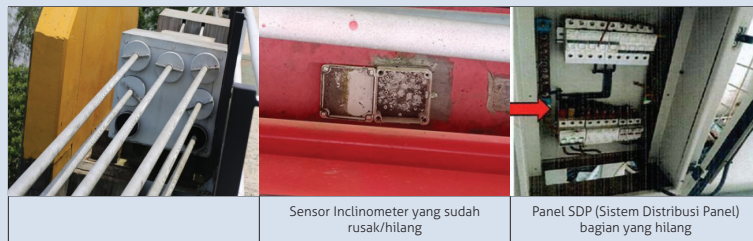
Gambar 71 Ilustrasi kode kerusakan 941 Hilang/lepas
