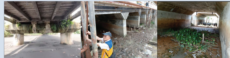
Gambar 36 Ilustrasi kode kerusakan 501 Pendangkalan sungai akibat endapan (agradasi)
