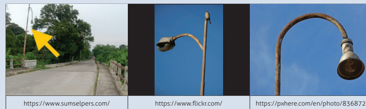
Gambar 68 Ilustrasi kode kerusakan 921 Penurunan mutu bahan/deteriorasi
