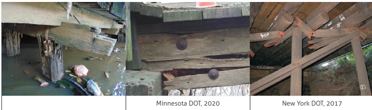
Gambar 23 Ilustrasi kode kerusakan 401 Pecah/belahnya kayu
