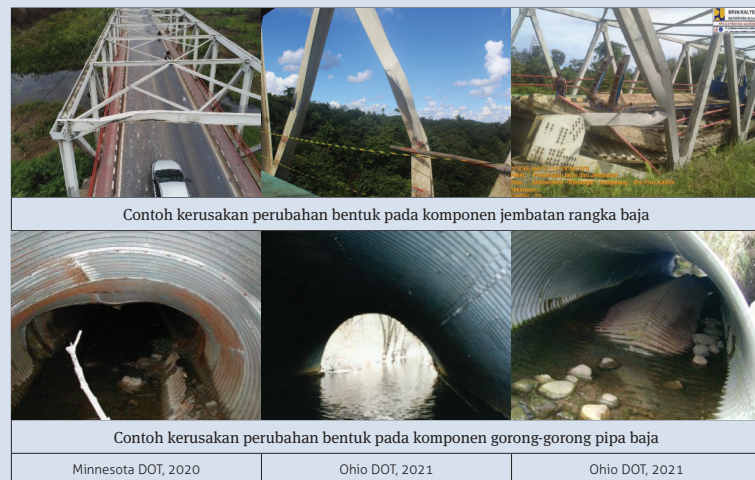
Gambar 16 Ilustrasi kode kerusakan 303 Perubahan bentuk pada komponen
