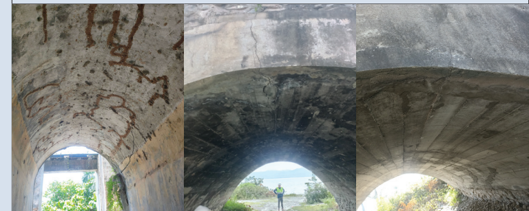
Gambar 9 Ilustrasi kode kerusakan 202 Retak (elemen beton)
