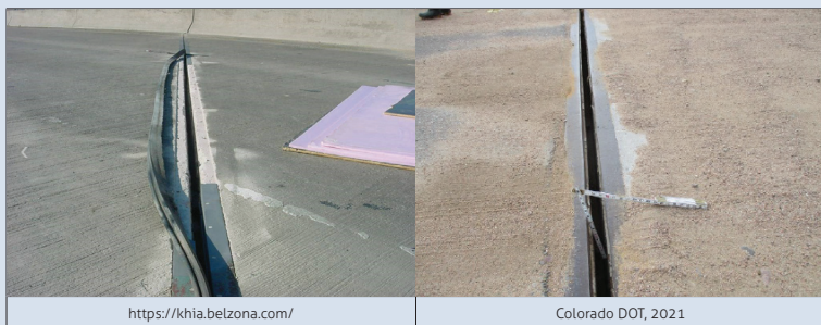
Gambar 57 Ilustrasi kode kerusakan 804 Lepasnya ikatan
