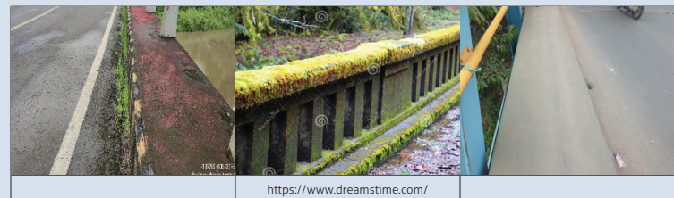
Gambar 51 Ilustrasi kode kerusakan 731 Permukaan trotoar licin
