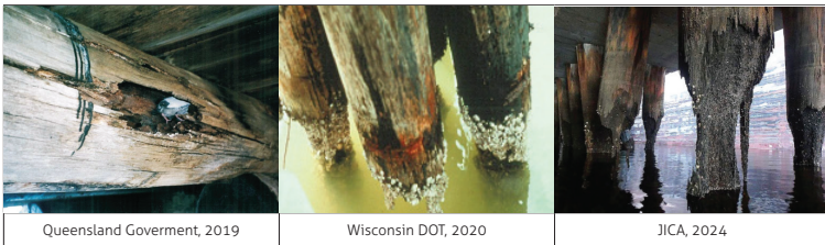
Gambar 22 Ilustrasi kode kerusakan 401 Serangan serangga
