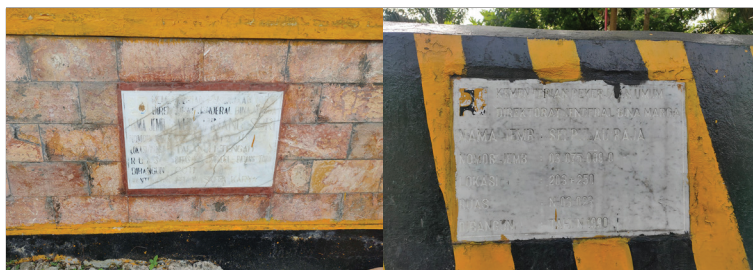
Gambar 66 Ilustrasi kode kerusakan 911 Tulisan tidak jelas
