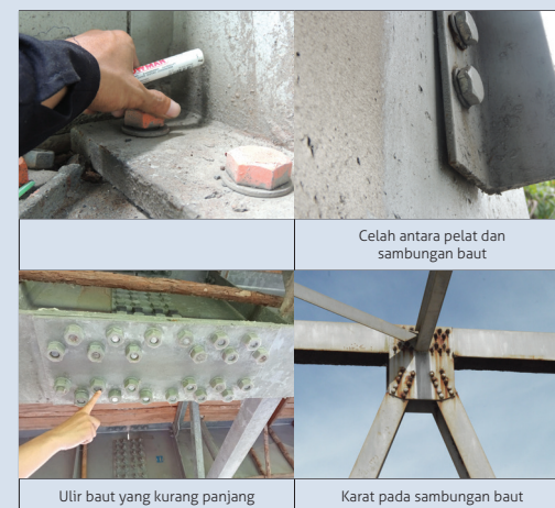
Gambar 20 Ilustrasi kode kerusakan 308 Sambungan yang longgar dan karat
