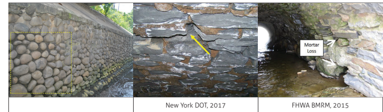
Gambar 2 Ilustrasi kode kerusakan 101 Penurunan mutu bata/batu
