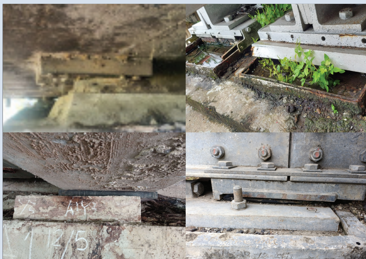
Gambar 63 Ilustrasi kode kerusakan 604 Perpindahan yang berlebih
