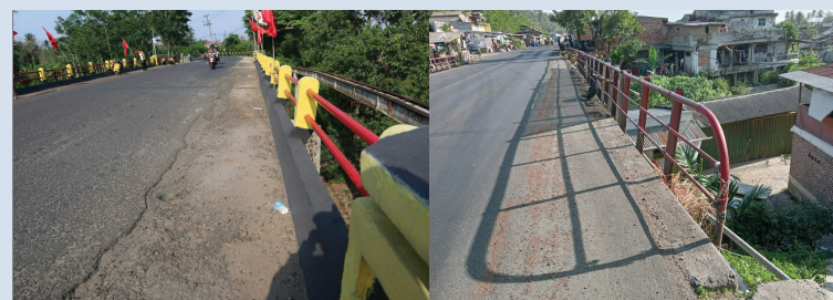
Gambar 53 Ilustrasi kode kerusakan 733 Bagian yang hilang/tidak ada
