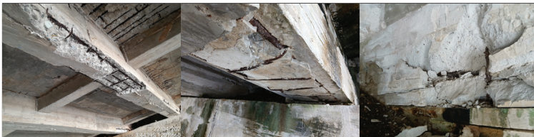
Gambar 6 Ilustrasi kode kerusakan 201 Beton rontok/spalling
