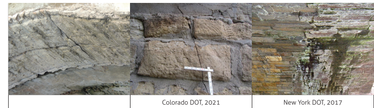
Gambar 3 Ilustrasi kode kerusakan 101 Keretakan
