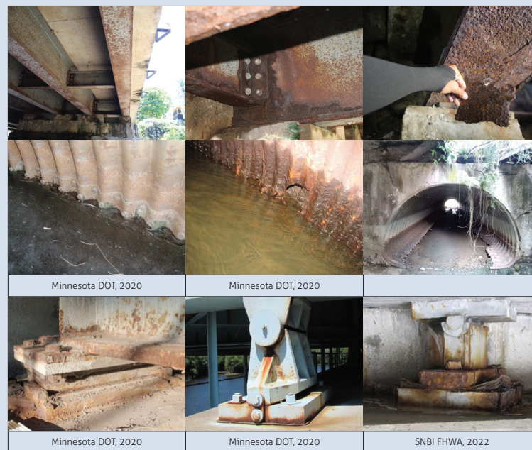
Gambar 15 Ilustrasi kode kerusakan 302 Karat
