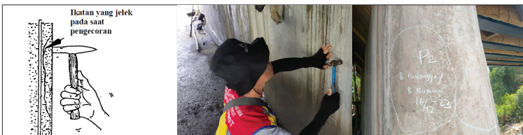
Gambar 8 Ilustrasi kode kerusakan 201 Beton berongga
