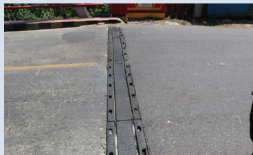
Gambar 56 Ilustrasi kode kerusakan 803 Bagian yang longgar
