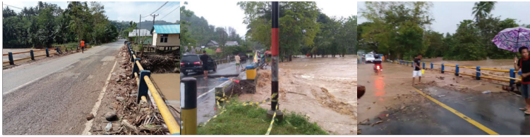
Gambar 39 Ilustrasi kode kerusakan 504 Air sungai macet yang mengakibatkan terjadinya banjir ( excess afflux )
