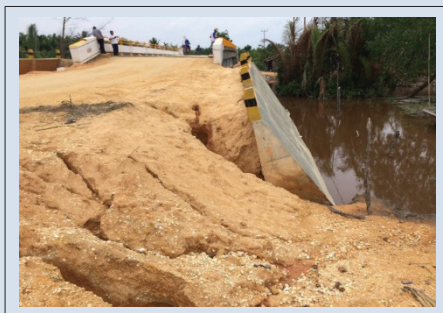
Gambar 32 Ilustrasi kode kerusakan 522 Retak, pengembangan
