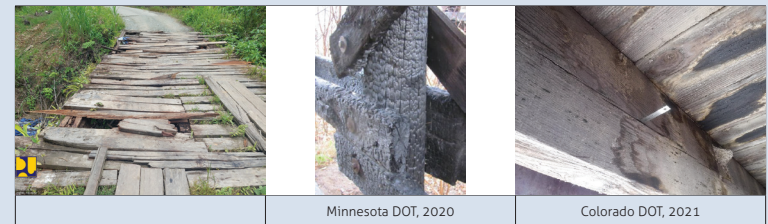
Gambar 26 Ilustrasi kode kerusakan 402 Komponen yang rusak atau hilang (termasuk retak, delaminasi)
