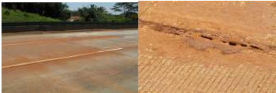
Gambar 3.1 Kerusakan *pumping* pada perkerasan beton
