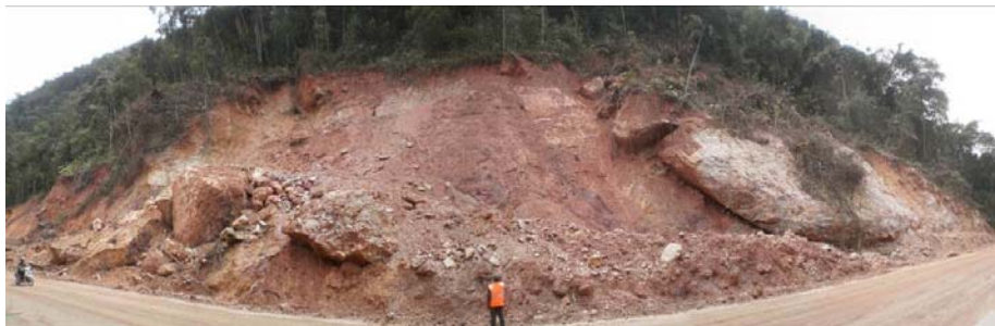
Gambar 5.6 Longsoran Akibat Ketidakstabilan Tebing
