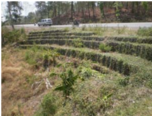
Gambar 4.18 Konstruksi Bronjong yang Telah Bertahan Lama
