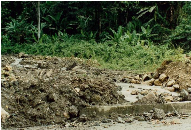
Gambar 5.10 Longsoran Badan Jalan Akibat Limpasan Saluran Tepi
