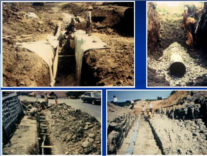
Gambar 4.9 Sistem Drainase Bawah Permukaan
