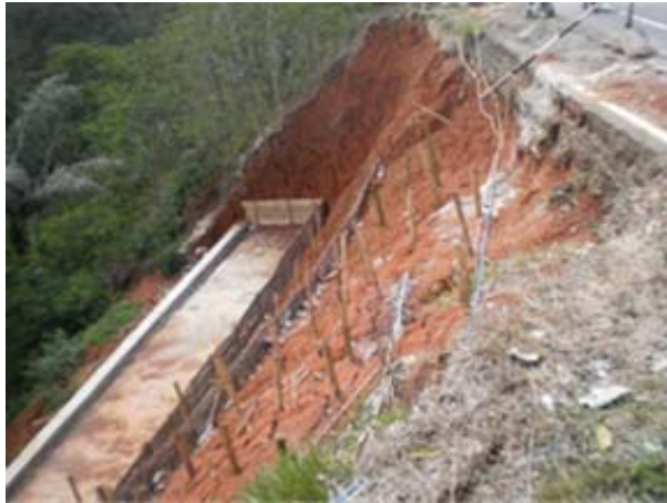
Gambar 5.12 Amblasan Jalan
