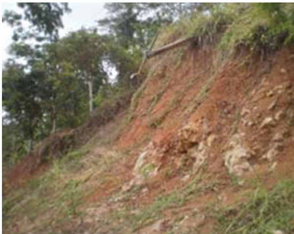
Gambar 5.4 Longsor Tebing Akibat Penjenuhan Tanah
