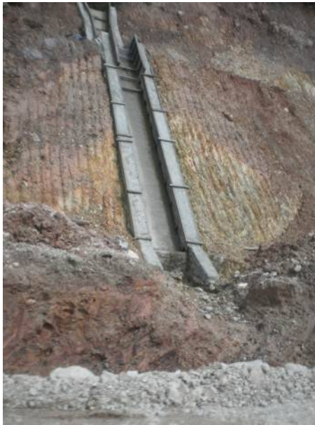
Gambar 4.8 Saluran Air dengan Terjunan
