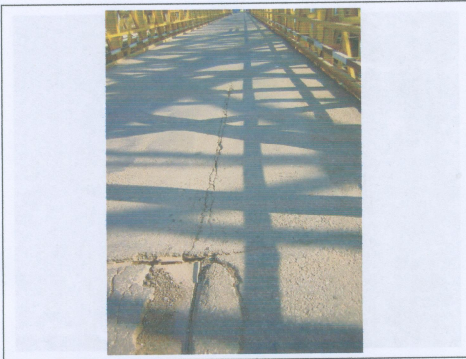
Gambar 4.2 : Kerusakan pelat lantai pada Jembatan Kedung Gede B
