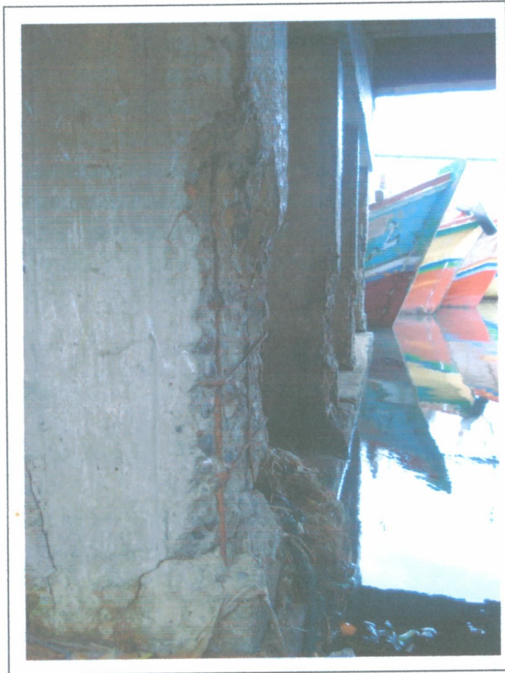
Gambar 4.12 : Kondisi Pilar pada Jembatan Ciberes A
