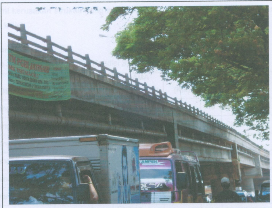
Gambar 4.1 : Jembatan Fly Over Cikampek (tanpa papan nama)
