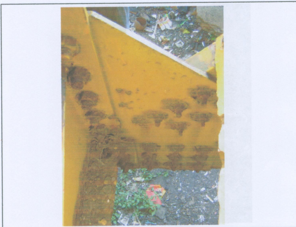
Gambar 4.2 : Kerusakan pelat lantai pada Jembatan Kedung Gede B
