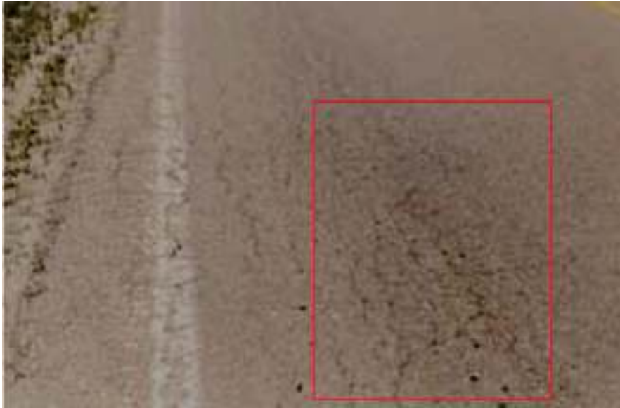
Gambar 2.2 - Permukaan perkerasan beraspal yang mengalami retak rambut
