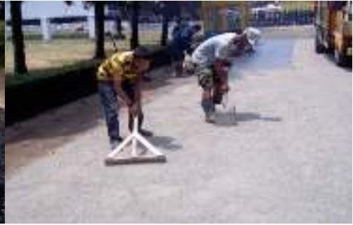
d. Penutupan dengan agregat penutup
