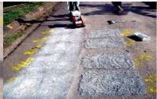
c. Pemasangan agregat penutup dengan variasi 6, 7 dan 8 kg/m 2
