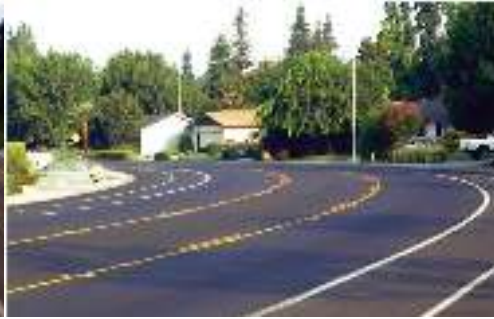
d. Permukaan perkerasan akhir setelah agregat penutup yang berlebih dibersihkan
