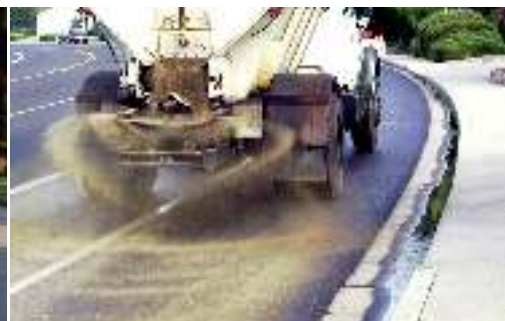
b. Penghamparan agregat penutup
