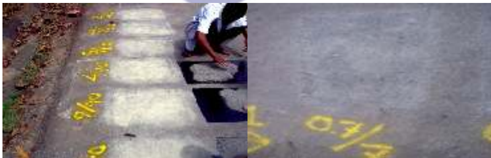
d. Proporsi aspal emulsi dan agregat penutup yang dipandang dapat menutup dengan baik celah retakan dan tanpa kelihatan berlebih
