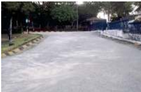
Gambar 4.5 - Uji coba skala kecil Laburan Aspal di lingkungan kampus Pusjatan
