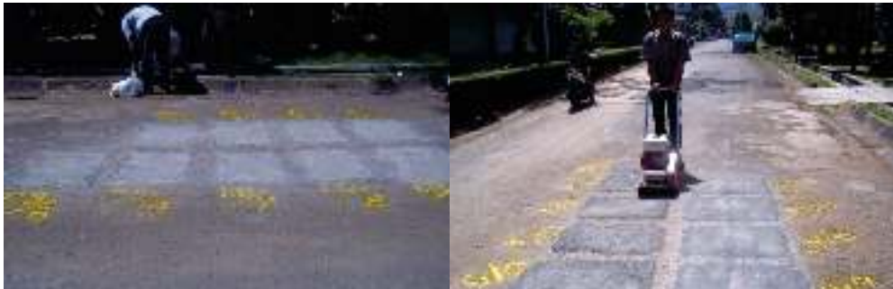
b. Pelaburan dengan aspal emulsi dengan variasi kadar residu 0,8; 0,9 dan 1,0 kg/m 2
