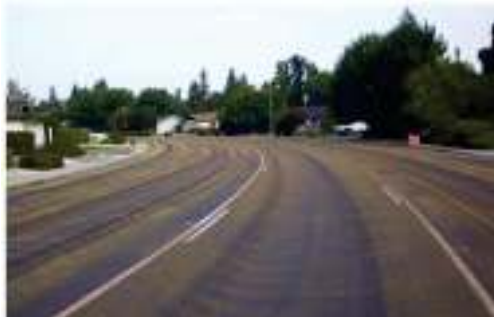
c. Hasil penghamparan agregat penutup
