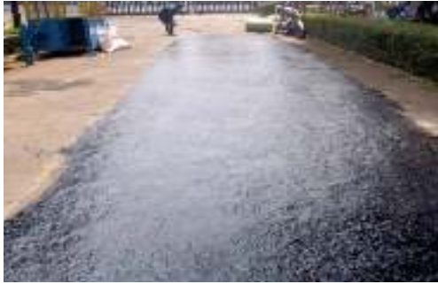
c. Hasil penyemprotan aspal emulsi
