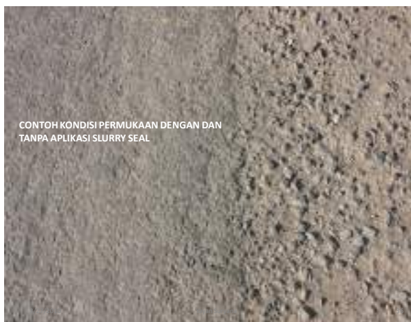
Gambar 3. Contoh Kondisi Permukaan Dengan dan Tanpa Aplikasi Slurry Seal
