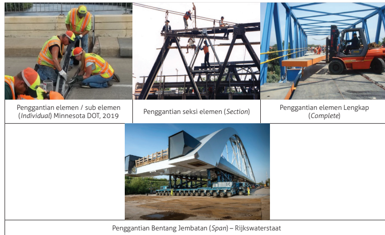
Gambar 9 Penjelasan Gambar Kegiatan terkait dengan Penggantian (Replace)
