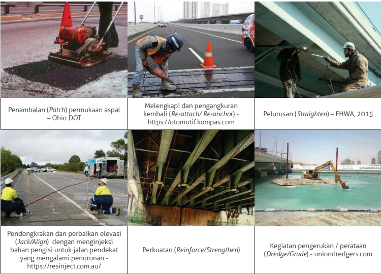
Gambar 8 Penjelasan Gambar Kegiatan terkait dengan Perbaikan (Repair)
