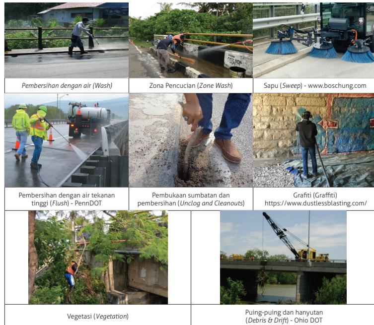
Gambar 5 Penjelasan Gambar Kegiatan terkait Pembersihan (Clean/Clear)
