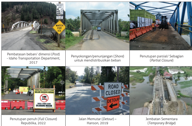
Gambar 11 Penjelasan Gambar Kegiatan terkait dengan Penanganan Darurat (Emergency)
