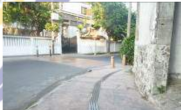
(b) Contoh penyediaan kemiringan permukaan trotoar sehingga pejalan kaki dimudahkan dalam melakukan perjalanan.
