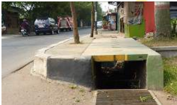
(b) Trotoar tidak dilengkapi kemiringan permukaan trotoar
