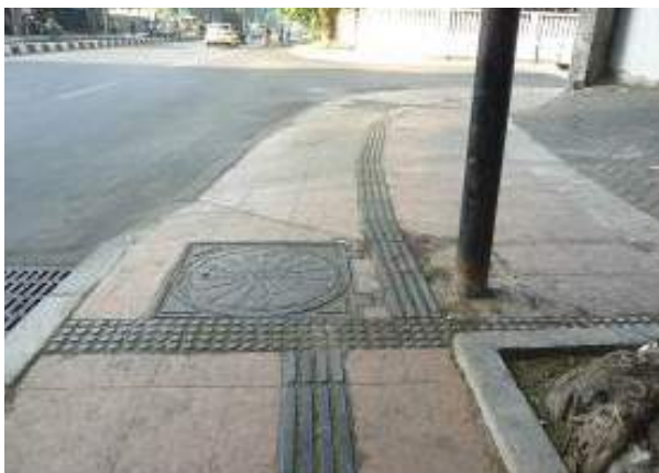
Gambar 4- 8 Contoh permukaan ubin pengarah orang cacat yang licin (Sumber: Survey Lapangan Surabaya, 2011)
