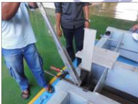
Gambar 33 Pengencangan baut dengan torsimeter
