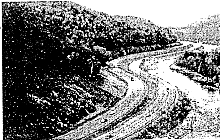
Gambar 2-13 Contoh desain jalan menyesuaikan dengan kondisi bentuk sungai
