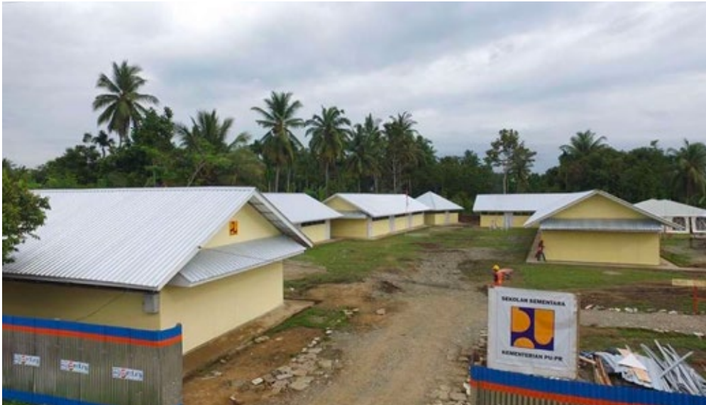
Pembangunan Sekolah di Kabupaten Pidie Jaya dan Bireun, Pasca Gempa Bumi pada Tahun 2016
