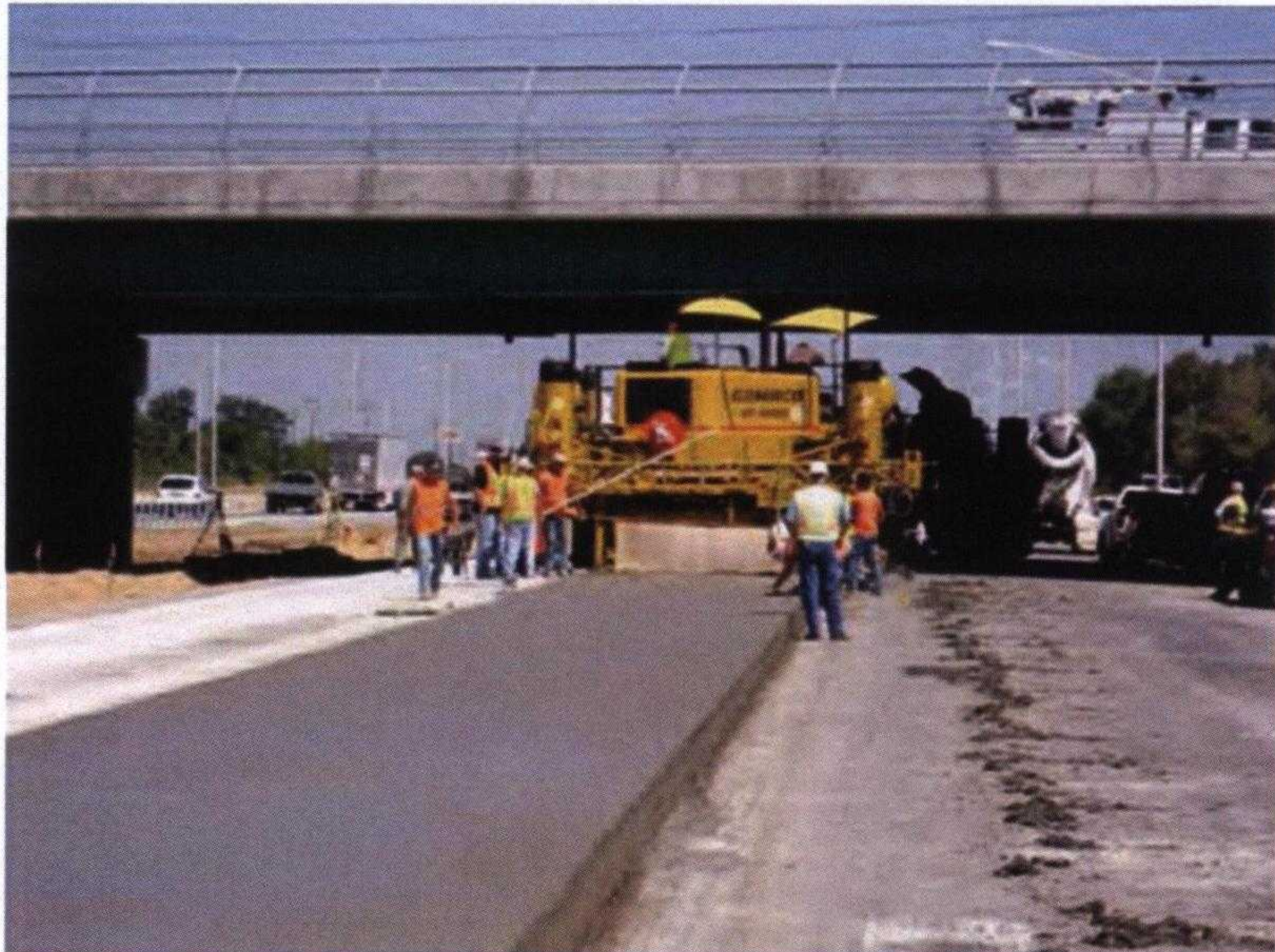
Gambar 4.7 Penghampar beton jenis acuan bergerak ( slip-form ) (Sumber: FHWA, 2016)
