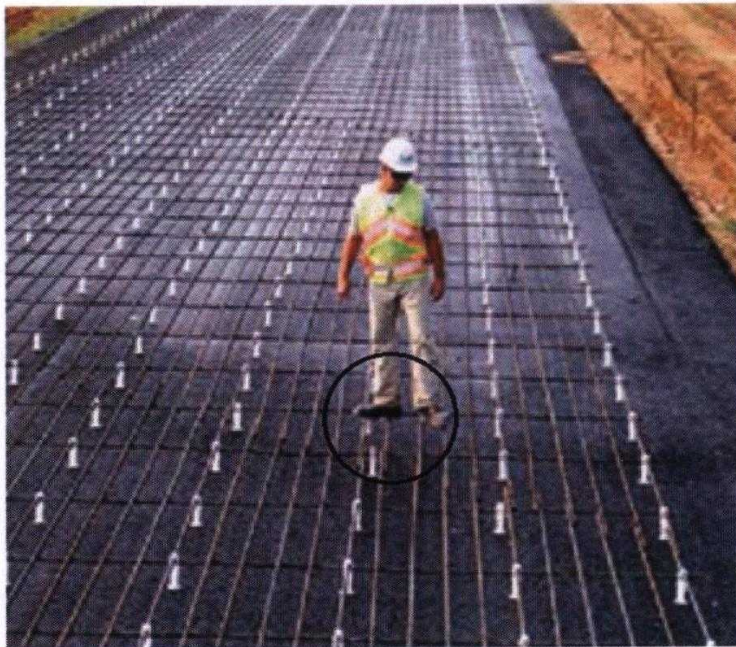
Gambar 4.2 Pekerja memeriksa baja tulangan memanjang dan melintang pada tumpuannya ( Sumber: FHWA, 2016 )
