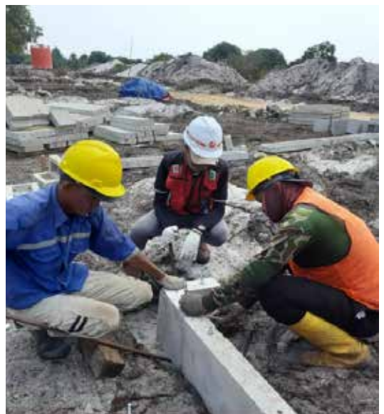
2.30 Aksesoris penyambung antar-panel RISHA. Sumber: Laporan Pekerjaan Mingguan Penyedia Jasa
