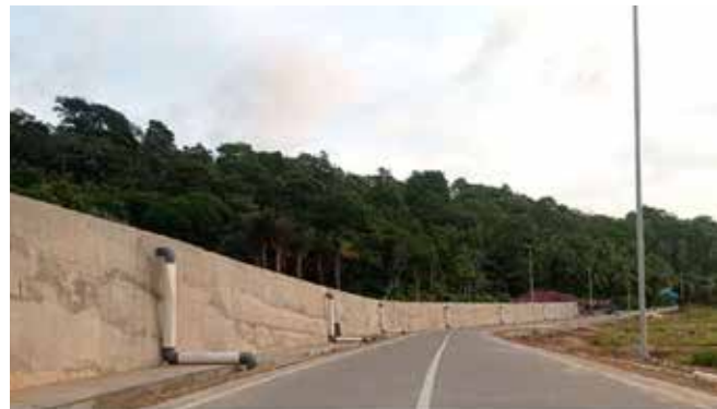
3.22-23 Foto pekerjaan jalan. Sumber: BPJN
