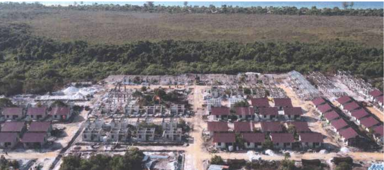
2.32 Dokumentasi Minggu 9 Pemasangan menyeluruh kawasan Huntap Serasan, Sumber: Laporan Pekerjaan Mingguan Penyedia Jasa
