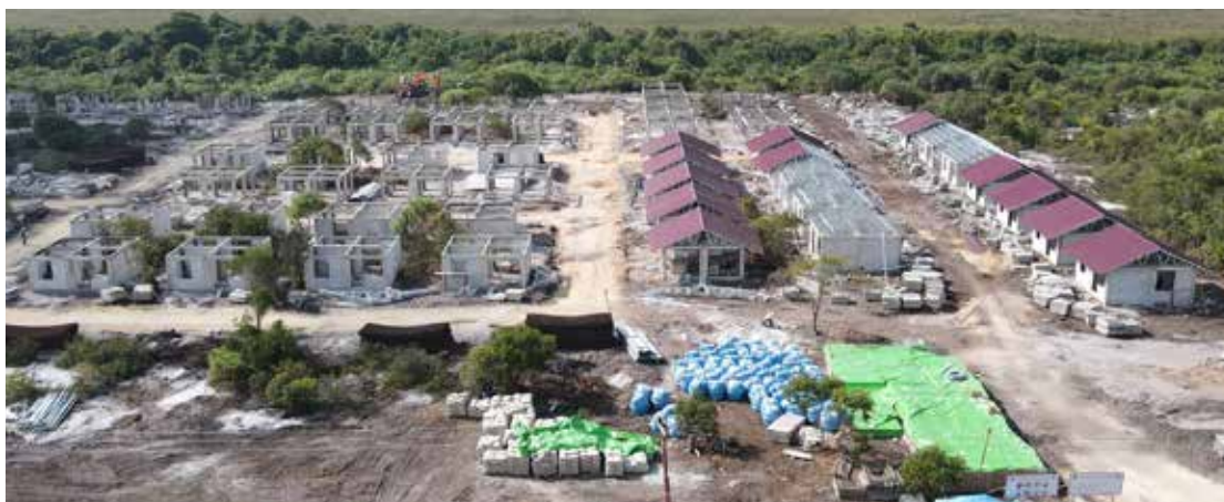
3.8 PDokumentasi langirsan material dan proses pembangunan. Sumber: Laporan Pekerjaan Mingguan Penyedia Jasa
