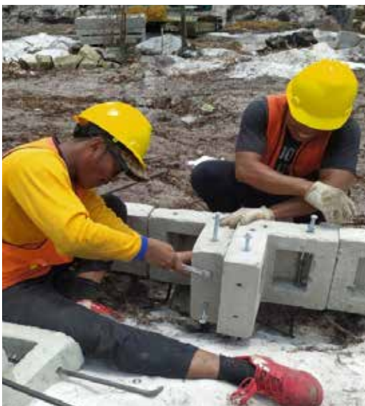
2.30 Aksesoris penyambung antar-panel RISHA. Sumber: Laporan Pekerjaan Mingguan Penyedia Jasa
