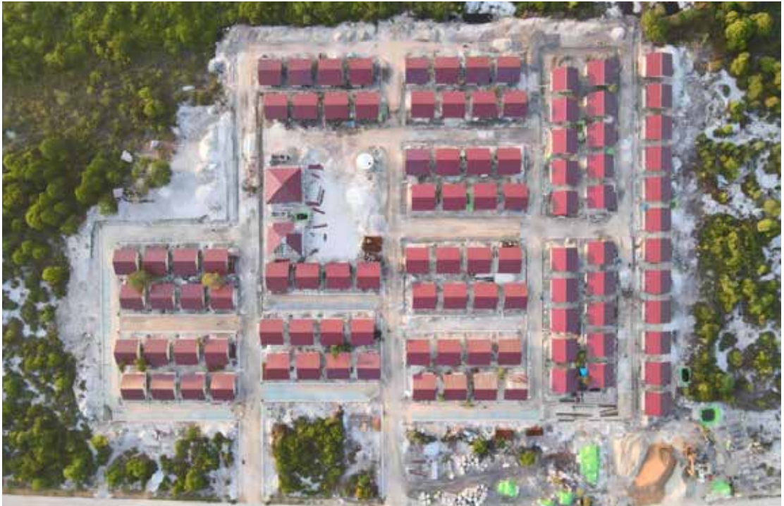
3.9 Tangkapan udara top-view perkembangan konstruksi Huntap. Sumber: Laporan Pekerjaan Mingguan Penyedia Jasa
