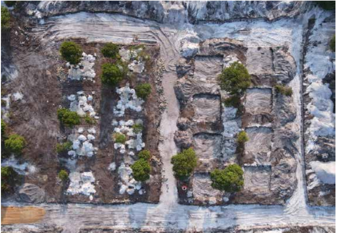
3.3 Pekerjaan pengurugan awal dan pembentukan jalan. Sumber: Laporan Pekerjaan Mingguan Penyedia Jasa
