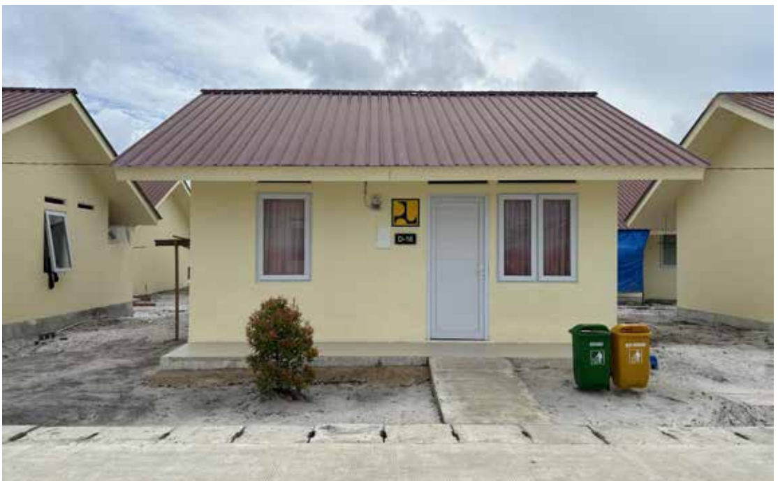
3.13-14 Foto tampak depan dan samping unit Huntap. Sumber: Laporan Pekerjaan Mingguan Penyedia Jasa
