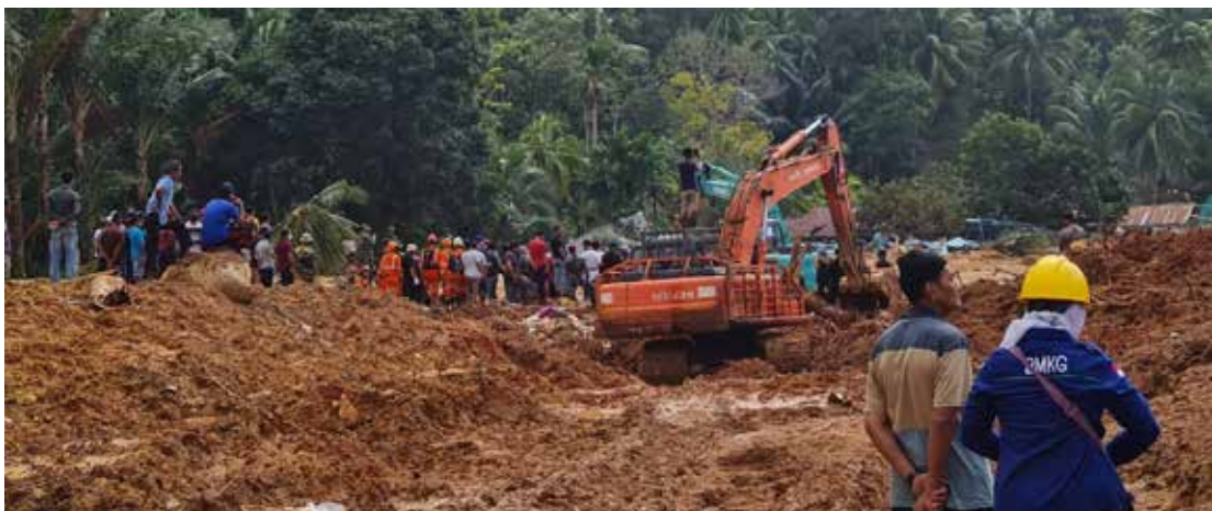
1.7 Pengerahan alat berat untuk pembersihan jalan di lokasi longsor. Sumber: PUPR
