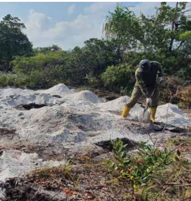
3.4-5 Pekerjaan pengurugan awal dan pembentukan jalan. Sumber: Laporan Pekerjaan Mingguan Penyedia Jasa
