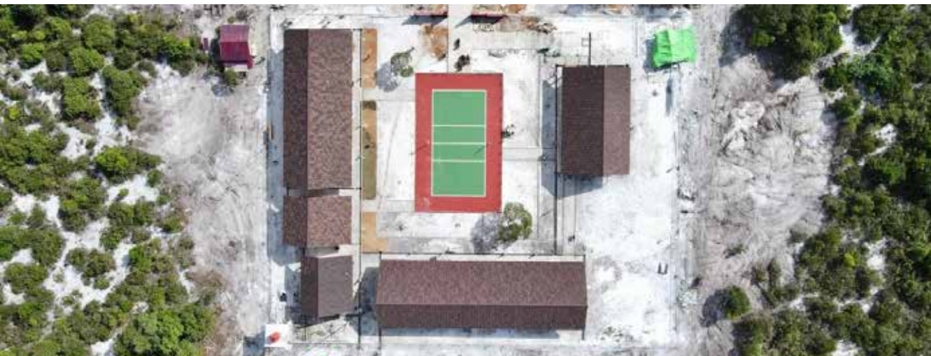
2.37 dokumentasi pekerjaan sekolah pasca konstruksi. Sumber: Laporan Pekerjaan Mingguan Penyedia Jasa
