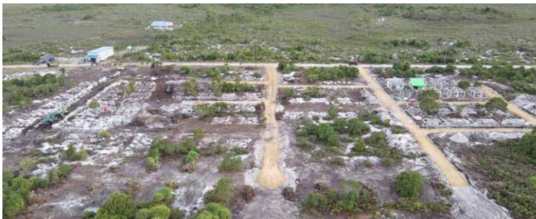
3.7 Pekerjaan pengurugan awal dan pembentukan jalan. Sumber: Laporan Pekerjaan Mingguan Penyedia Jasa
