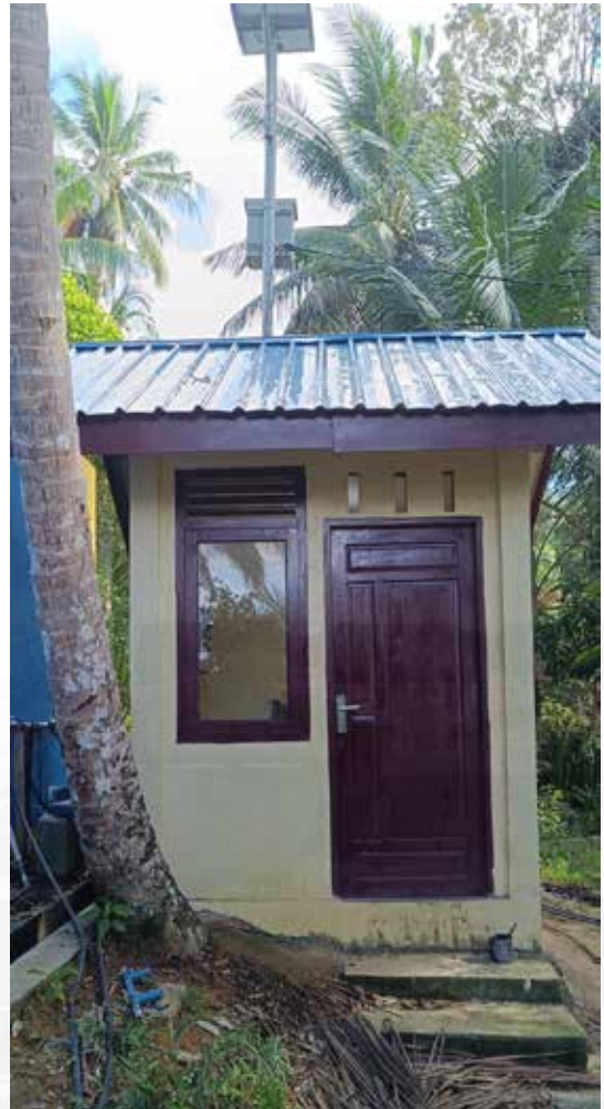
2.13 Rumah Pompa Jaringan Pipa Air Baku ke Huntap. Sumber: BWS Sumatera IV
