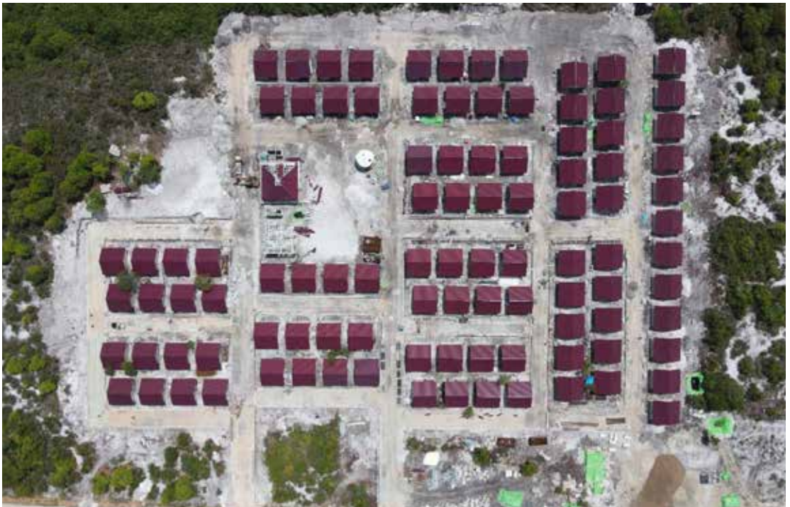
2.34 Dokumentasi Minggu 160 & 171 untuk pekerjaan pengecoran jalan. Sumber: Laporan Pekerjaan Mingguan Penyedia Jasa
