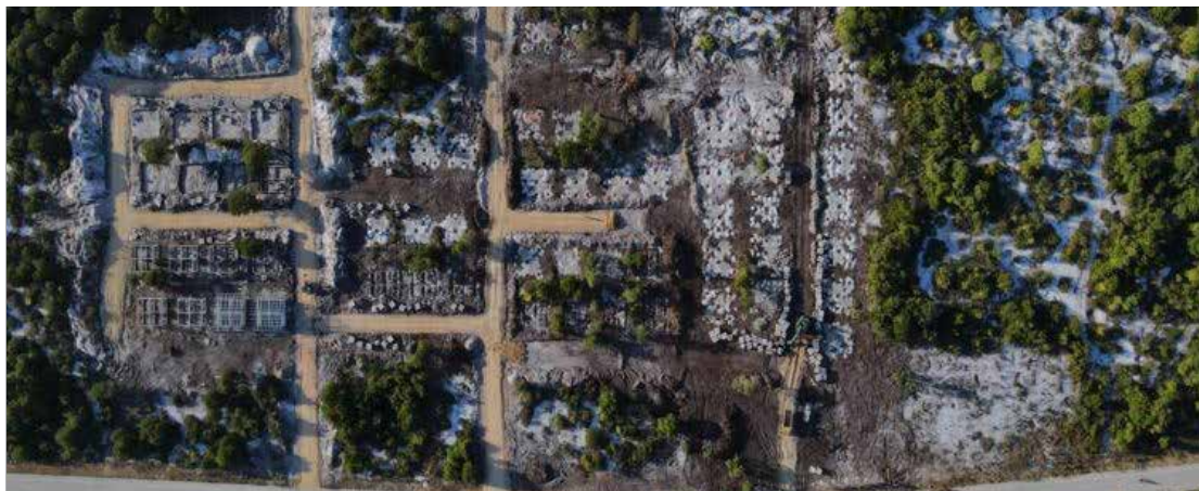
3.6 Pekerjaan pengurugan awal dan pembentukan jalan. Sumber: Laporan Pekerjaan Mingguan Penyedia Jasa
