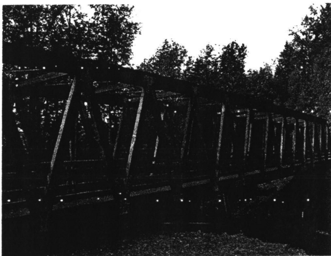
Gambar 2.5 Konstruksi Jembatan Rangka Kayu
