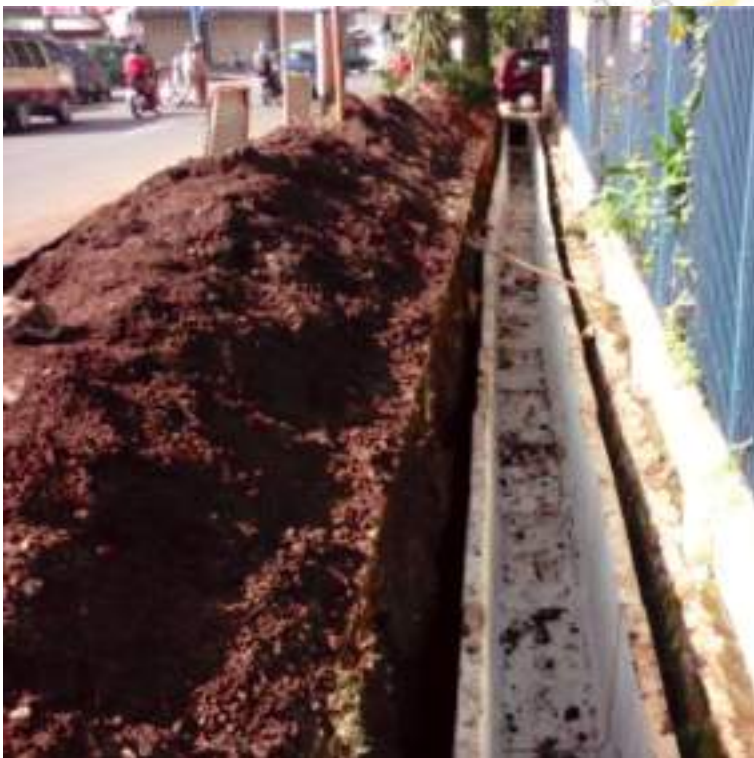
Gambar 25 - Pemasangan U-Ditch
