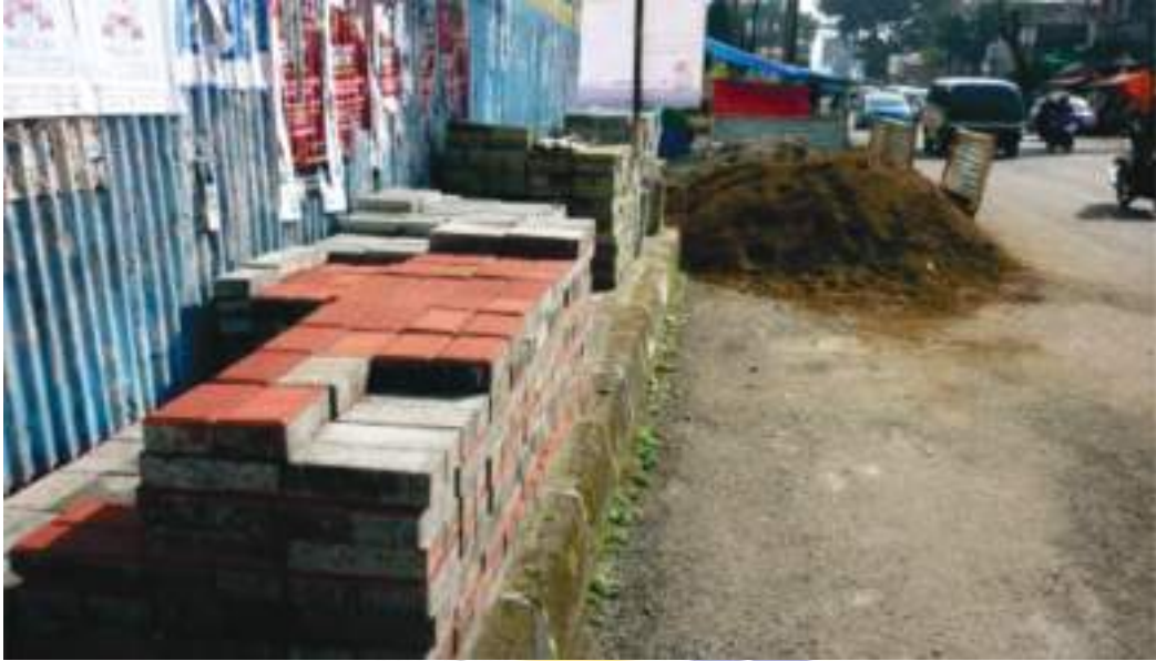
Gambar 6 - Persiapan Penerapan Paving
