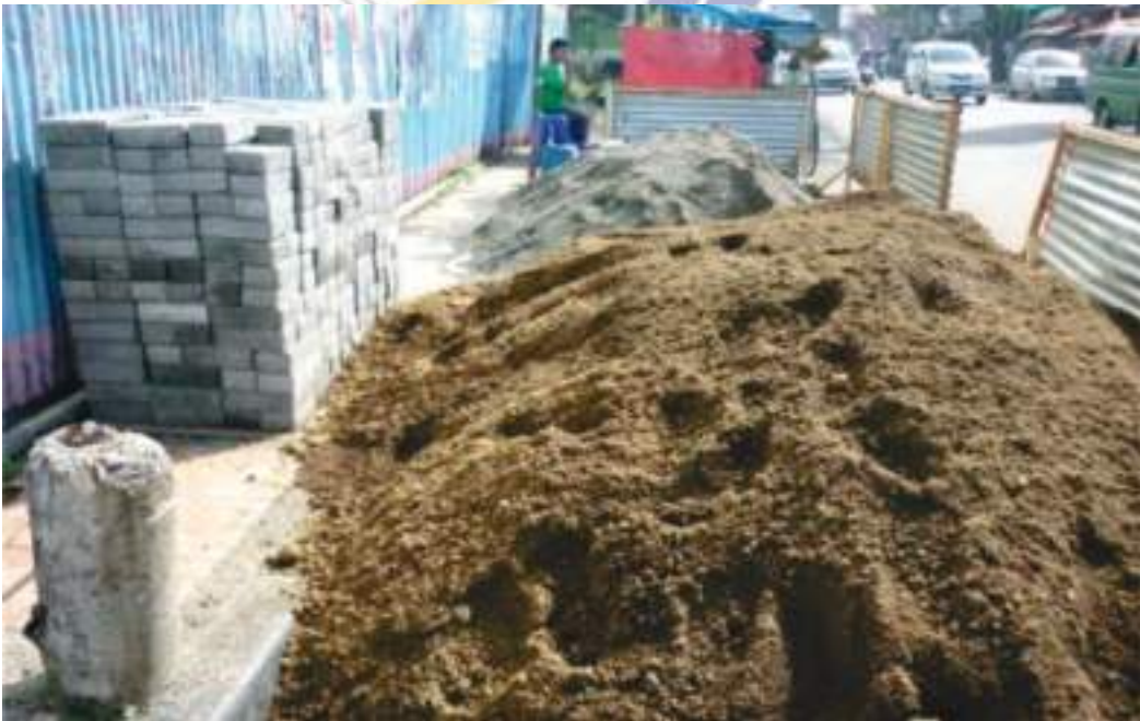
Gambar 7 - Persiapan Pasir Untuk Paving
