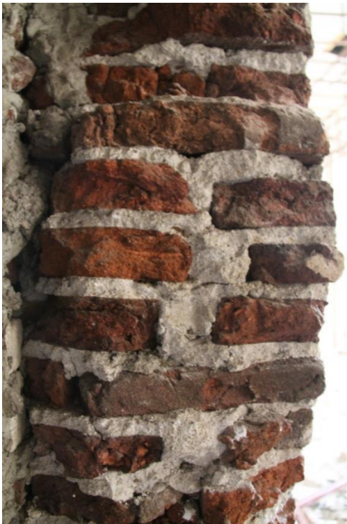
Gambar 63 Lubang pintu tambahan pada dinding lama, secara struktural lubang tersebut merupakan kelemahan, harus segera ada penanganan
