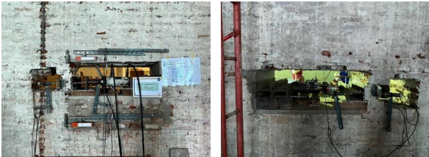
Gambar 119 Dokumentasi pengujian geser in situ Gedung AA Maramis (sumber : Dit BTTP)
