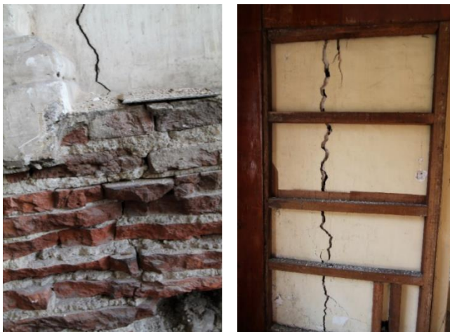
Gambar 65 Contoh dinding yang mengalami retak tembus
