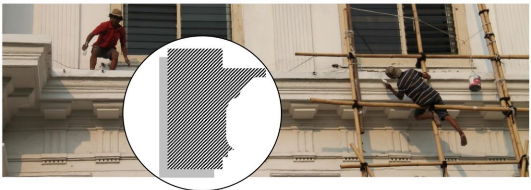
Gambar 53 Pembuatan pola ornamen pada dinding luar bangunan
