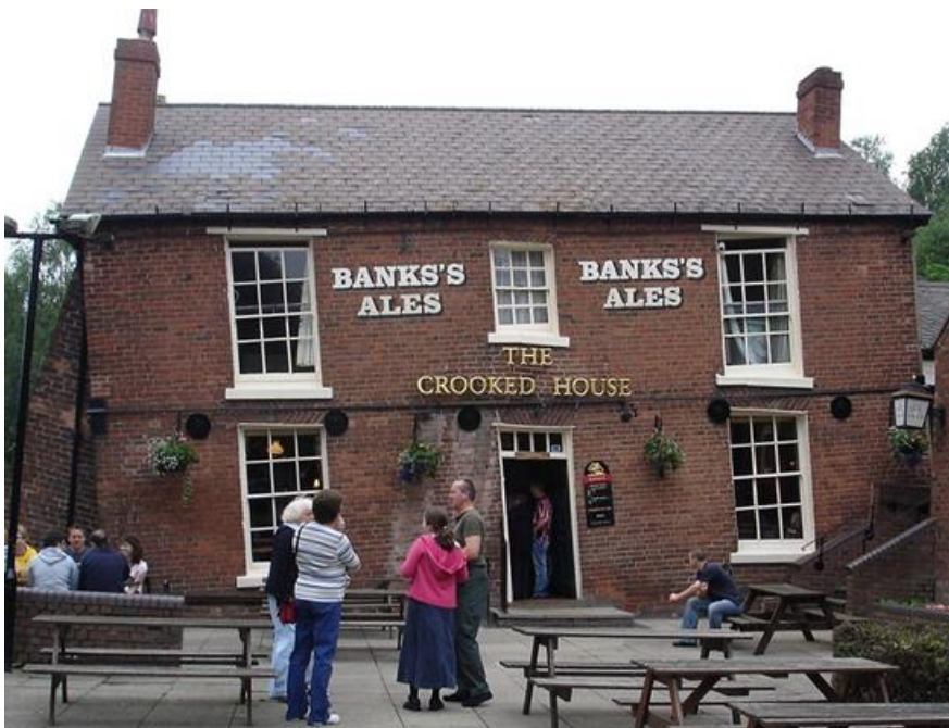
Gambar 28 Contoh bangunan yang mengalami perubahan bentuk
