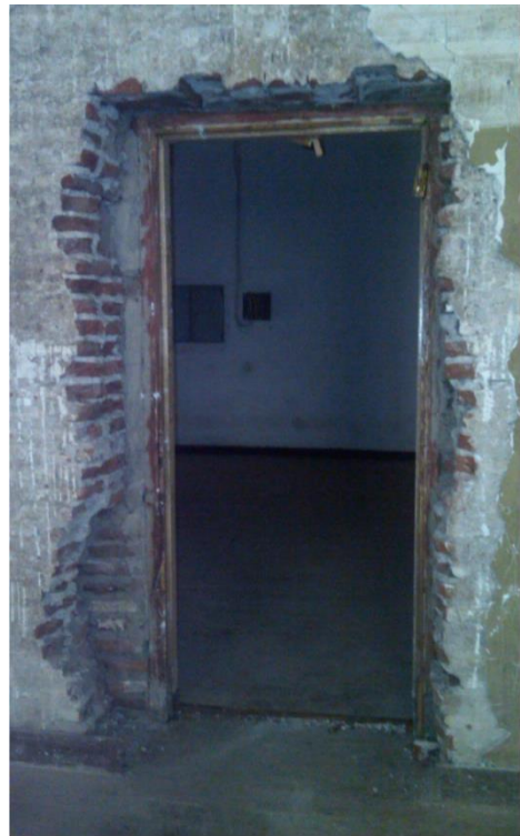
Gambar 63 Lubang pintu tambahan pada dinding lama, secara struktural lubang tersebut merupakan kelemahan, harus segera ada penanganan
