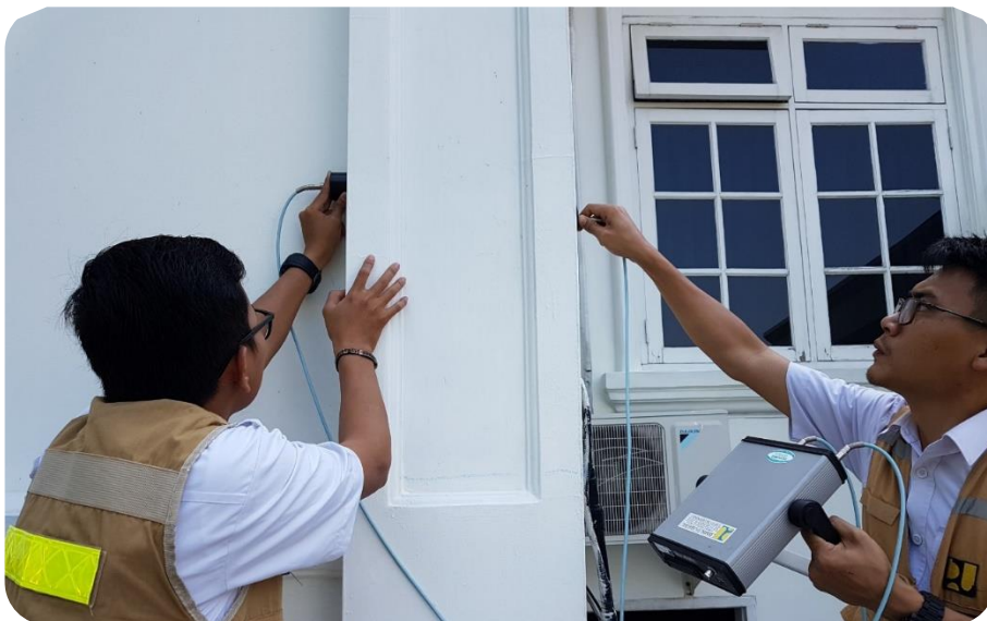
Gambar 115 Contoh pelaksanaan pengujian ultrasound pada bangunan heritage
