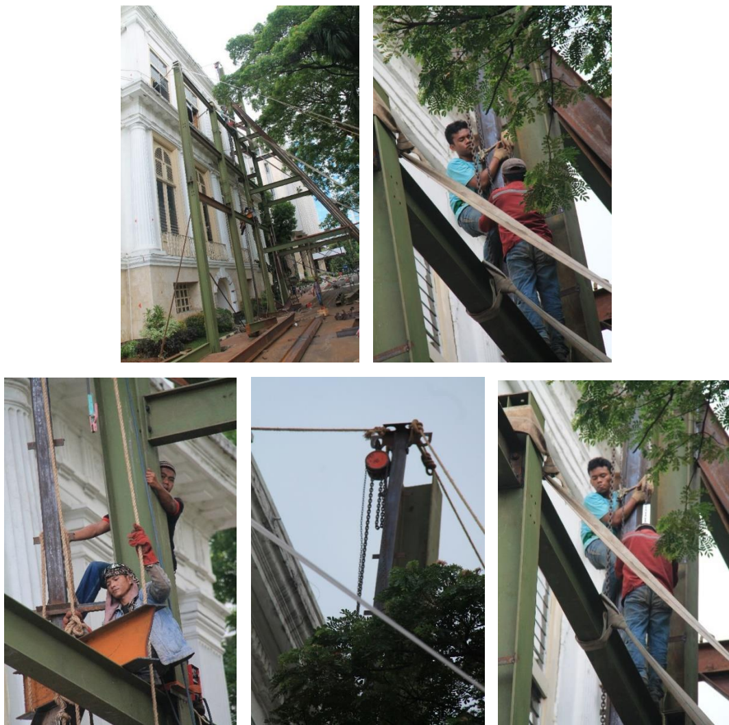
Gambar 41 Kegiatan perkuatan sementara pada Bangunan Sayap Selatan
