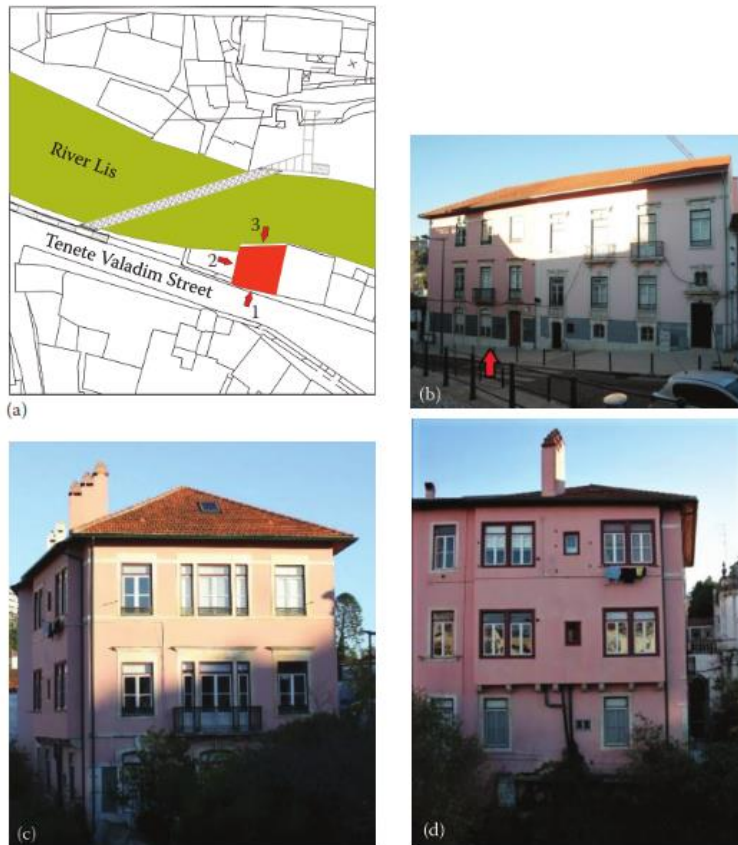
Gambar 128 Lokasi dan tampak eksterior bangunan studi kasus ke-2 (sumber : Silva, Velodu & Santos)
