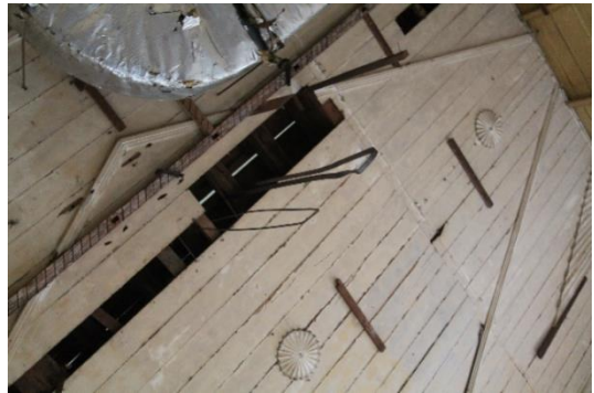
Gambar 96 Kondisi penutup plafon setelah proses pengupasan
