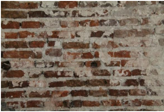
Gambar 55 Setelah pengupasan plesteran dinding dibersihkan dengan sikat kawat
