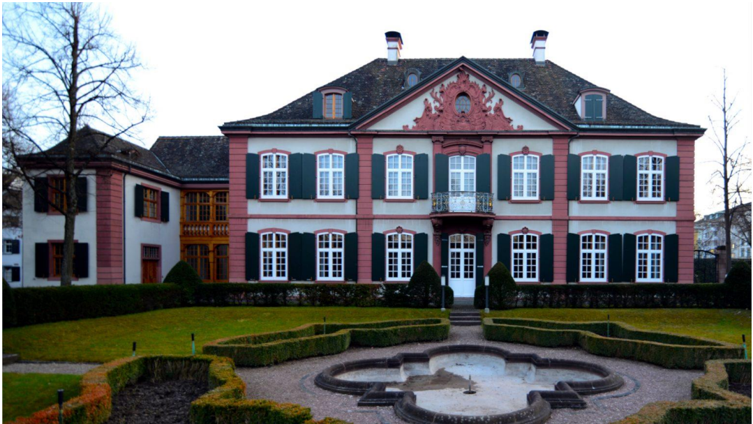
Gambar 105 Contoh bangunan tua di Eropa dengan sistem masonry, yang berkembang di Indonesia selama masa kolonialisasi (sumber : EESD Research Group, EPFL)
