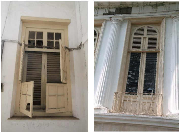
Gambar 47 Jendela yang masih asli dan jendela yang sudah mengalami perubahan
