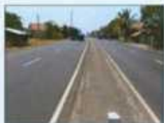
Kondisi lapis SMA 1" Stabit+0,3% Cell
