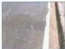
Deformasi perkerasan pada sisi bahu jalan
