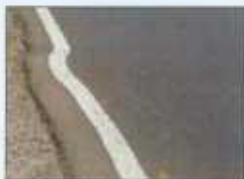
Deformasi perkerasan pada sisi bahu jalan
