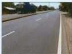
Kondisi lapis SMA 3/4" starbit+0,3% Cell
