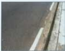
Deformasi perkerasan pada sisi median
