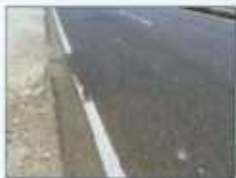
Deformasi perkerasan pada sisi bahu jalan
