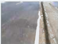
Deformasi perkerasan pada sisi bahu jalan
