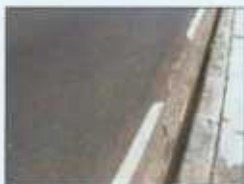
Deformasi perkerasan pada sisi median
