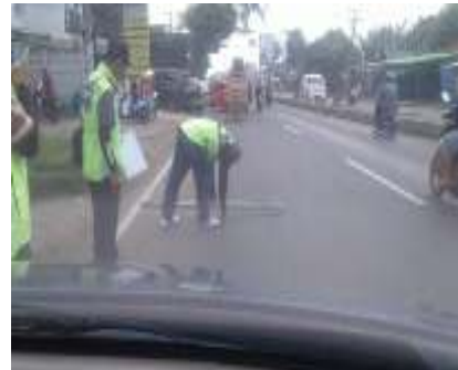
4). Pengukuran kedalaman alur
