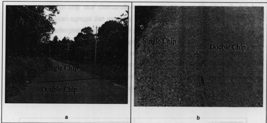
Gambar 4.7. Lapisan yang Menggunakan Single dan Double Chip Seal
