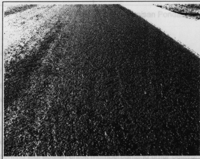
Gambar 2.6. Kondisi Permukaan Lapis Pondasi yang Sudah diberi Prime Coat
