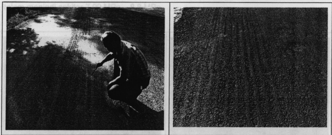
Gambar 4.10. Penampakkan Permukaan Akibat Kondisi atau Pengaturan Tinggi Nozzel Yang Kurang Baik
