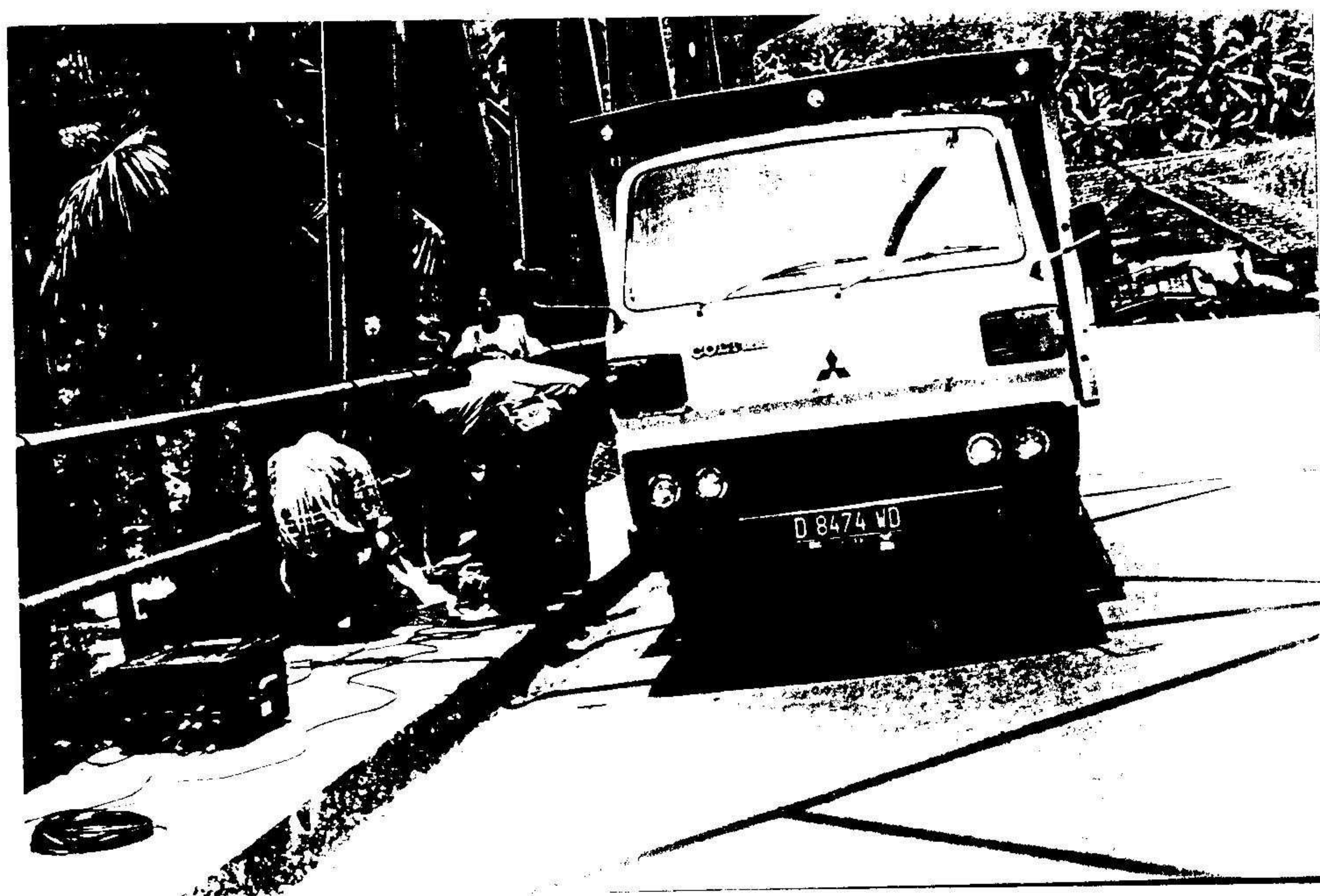
"Alat ukur pencatat getaran jembatan " Vibro Corder "
