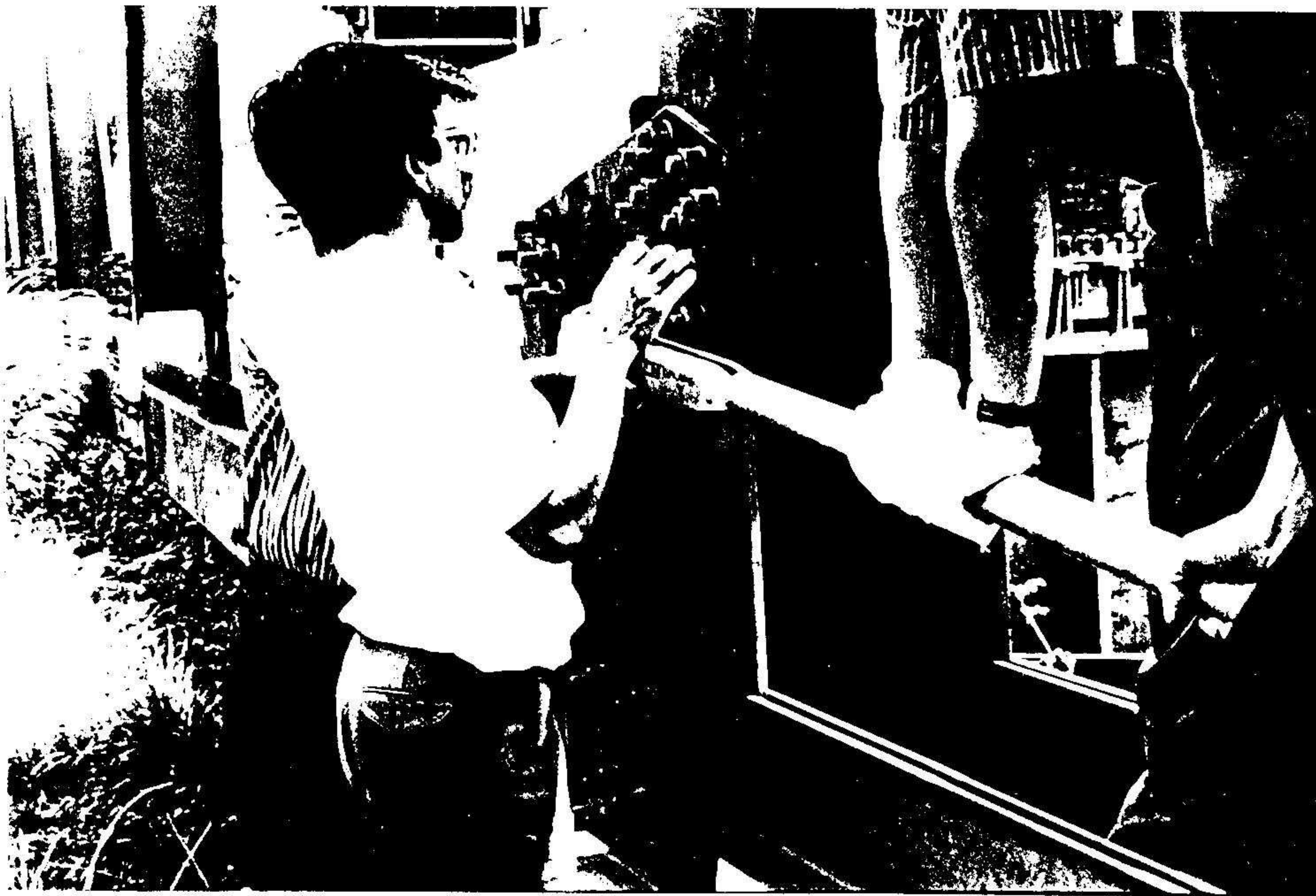
Pengujian dengan suara pukulan palu baja saat pengencangan bout.
