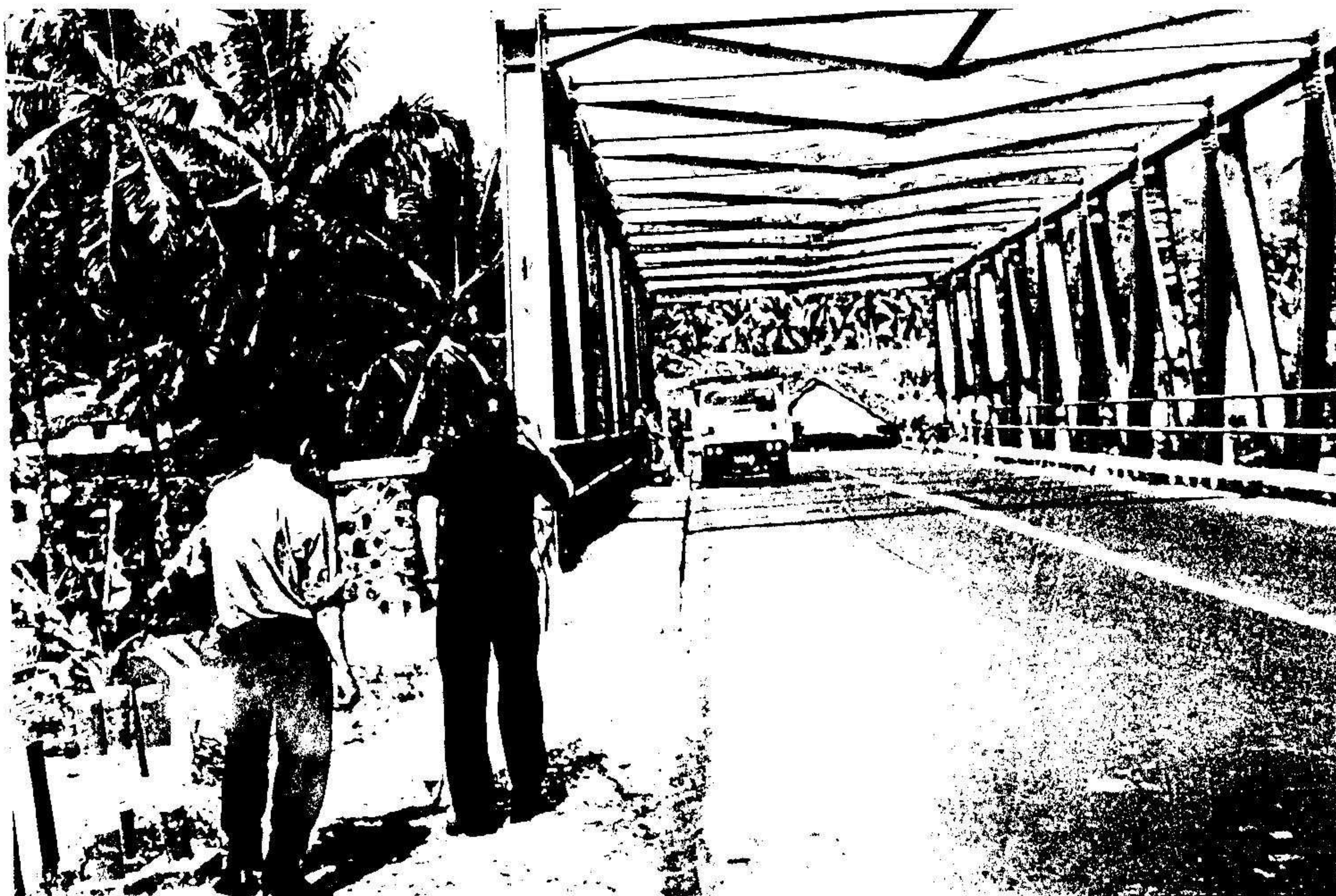
Pembacaan lendutan jembatan dengan menggunakan alat ukur water - pass
