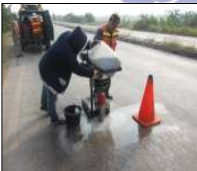
Gambar 6-5 Pengambilan benda uji dengan core drill
