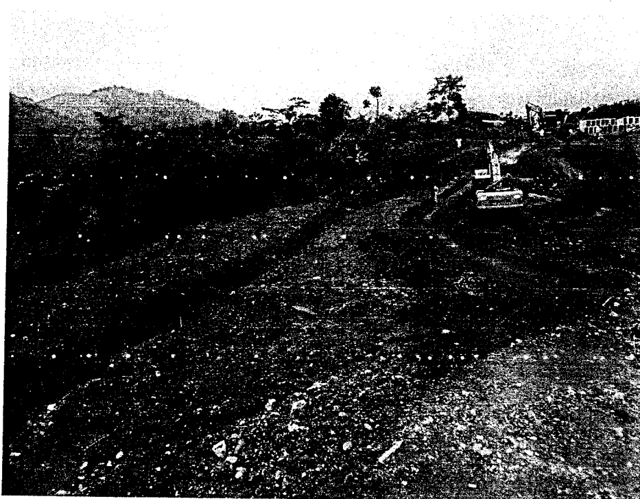
Gambar 4-15 longsor Wado Sumedang
