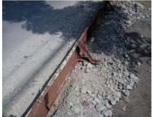
Gambar 90 Acuan tepi menggunakan pelat baja dengan tebal 1 mm
