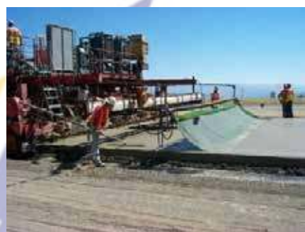
Gambar 32 Artificial turf yang ditarik
