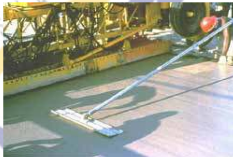
Gambar 62 Penekanan alat pelepa ( Bull float )
