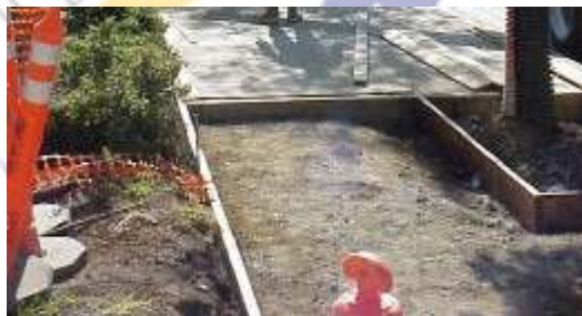
Gambar 5 Acuan tetap dari kayu untuk pekerjaan kecil
