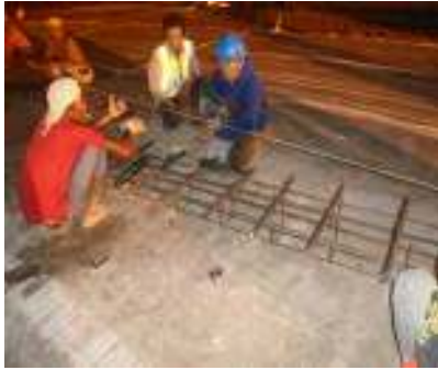
Gambar 80 Perakitan dowel
