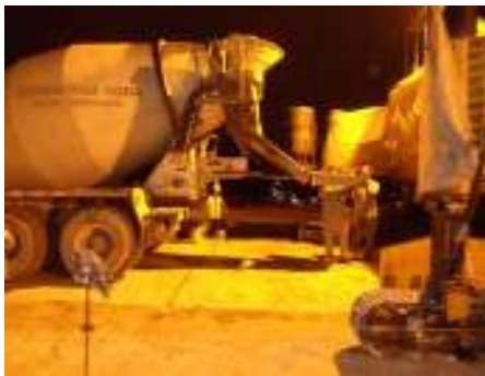
Gambar 82 Truck mixer menumpahkan beton segar
