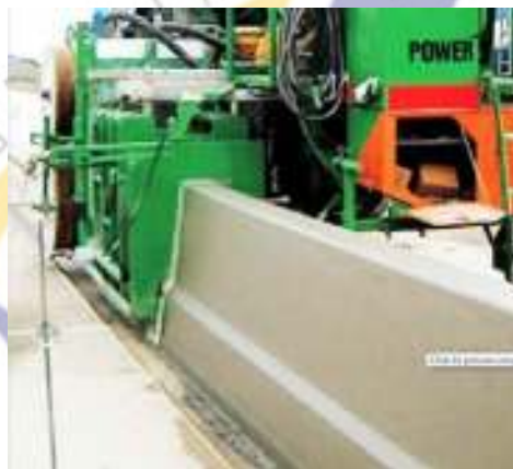
Gambar 40 Acuan bergerak untuk parapet
