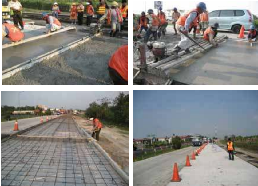
Gambar 16 Sistem acuan tetap pada pelaksanaan JRCP dan CRCP di Jalan Tol Tangerang-Merak
