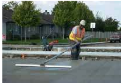
Gambar 22 Tining secara manual
