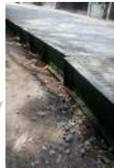
Gambar 90 Acuan tepi menggunakan pelat baja dengan tebal 1 mm
