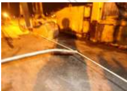
Gambar 78 Kabel pengendali (stringline)
