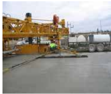
Gambar 59 Pelepa memanjang
