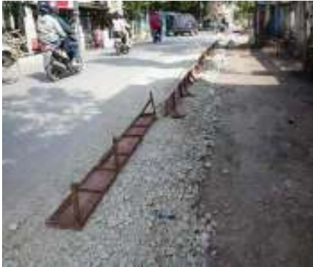
Gambar 90 Acuan tepi menggunakan pelat baja dengan tebal 1 mm
