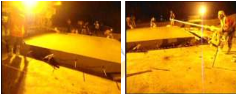
Gambar 88 Perataan dengan tangan (manual)
