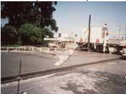
Gambar 60 Pelepa bentuk “V” yang ditarik mesin
