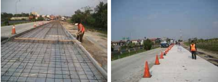
Gambar 3 Sistem acuan tetap pada pelaksanaan JRCP dan CRCP di Jalan Tol Tangerang-Merak
