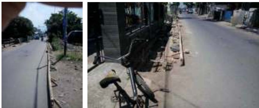
Gambar 97 Pemasangan acuan tepi
