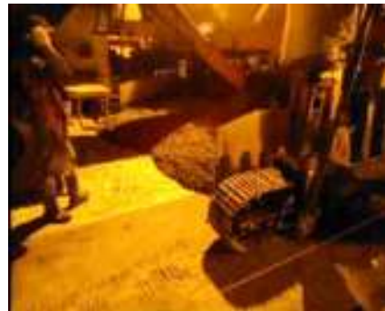
Gambar 83 Beton segar didorong auger untuk disebar selebar lajur
