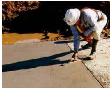
Gambar 61 Roskam tangan ( Hand Trowel ) untuk yang sulit dijangkau mesin
