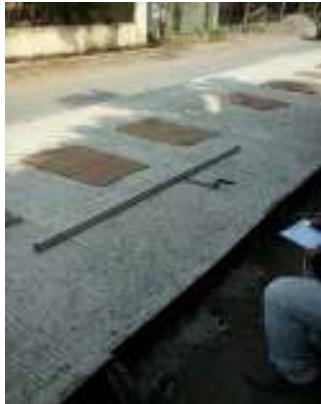
Gambar 94 Jalan beton semen dan perawatan beton yang tidak sempurna di jalan Golf Raya – Kota Bandung
