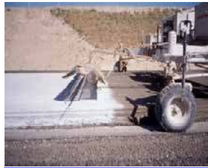
Gambar 35 Penyemprotan curing membrane
