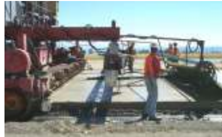
Gambar 30 Penyelesaian akhir dengan manual (hand finishing) di belakang penghampar
