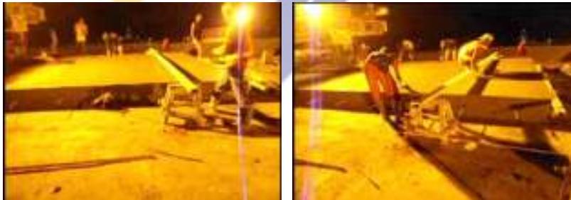
Gambar 89 Persiapan pembuatan tekstur
