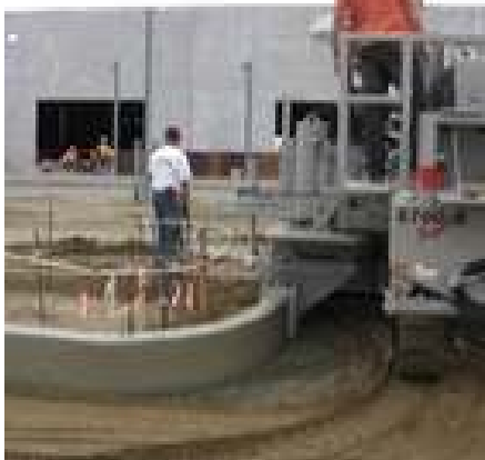
Gambar 38 Acuan bergerak untuk pagar pengaman
