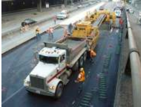
Gambar 26 Placer/spreader menerima beton segar dari dump truk dan menempatkannya di depan penghampar ( paver ).
