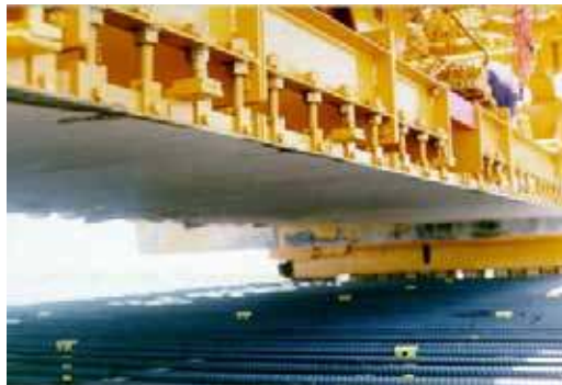
Gambar 57 Pelepa perata di bawah mesin penghampar acuan bergerak
