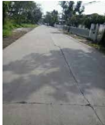
Gambar 94 Jalan beton semen dan perawatan beton yang tidak sempurna di jalan Golf Raya – Kota Bandung
