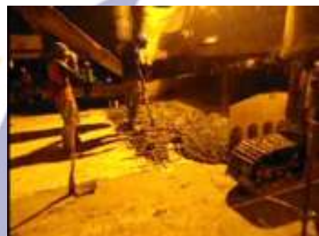
Gambar 85 Beton segar selanjutnya didorong auger untuk disebar selebar lajur
