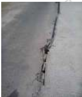
Gambar 92 Acuan tepi pada potongan memanjang yang tidak menerus
