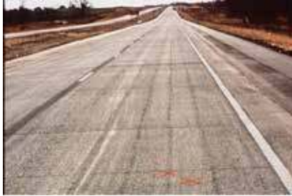
Gambar 56 Goresan vibrator yang tidak bekerja dengan benar.
