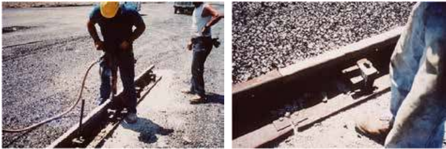
Gambar 6 Pemancangan pin menggunakan jackhammer dan pin yang sudah terpancang
