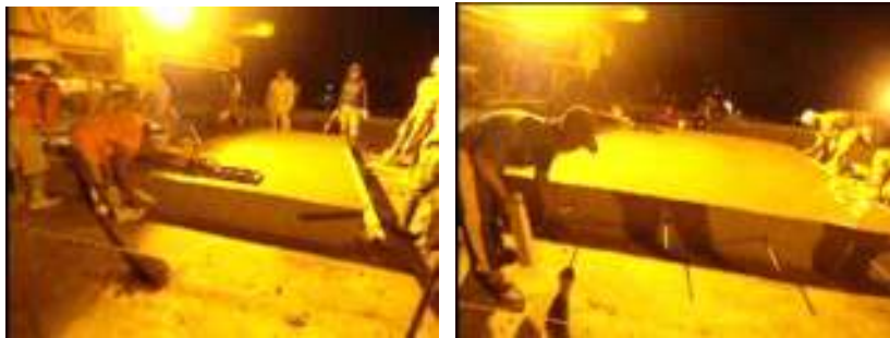
Gambar 87 Perataan dan pemasangan tie bar secara manual
