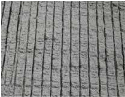
Gambar 70 Permukaan yang ditekstur dengan alat Tining
