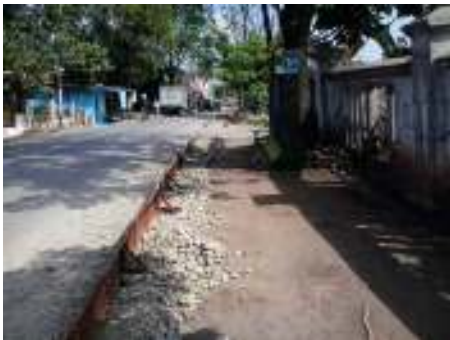
Gambar 91 Pemasangan acuan tepi
