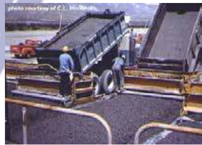
Gambar 25 Placer / spreader kecil
