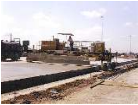
Gambar 34 Penyemprotan curing membrane
