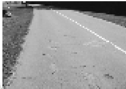
Gambar 3.21 Pelepasan Butir Keparahan Tinggi
