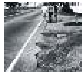
Gambar 3.6 Retak Tepi Keparahan Tinggi
