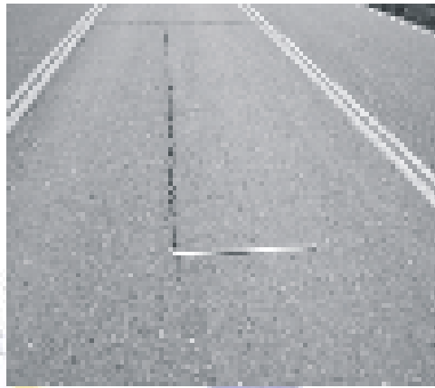
Gambar 3.7 Retak Memanjang Keparahan Tinggi
