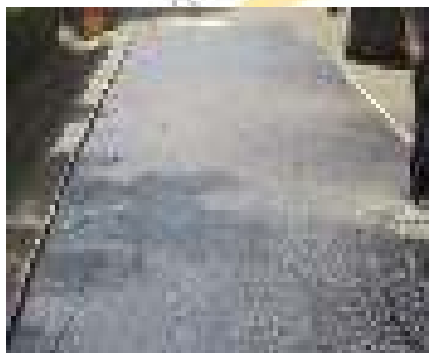
9.a. Pekerjaan Tack Coat
