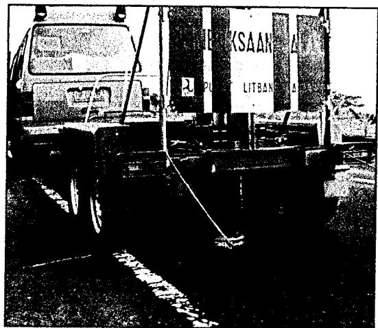
Gambar 4.10 Foto Kegiatan Pengukuran Lendutan dengan FWD
