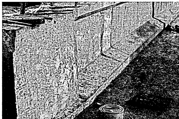
Gambar 5. Gelagar segmental tersambung
