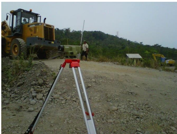
Pekerjaan Pembuatan Jalan (2)
