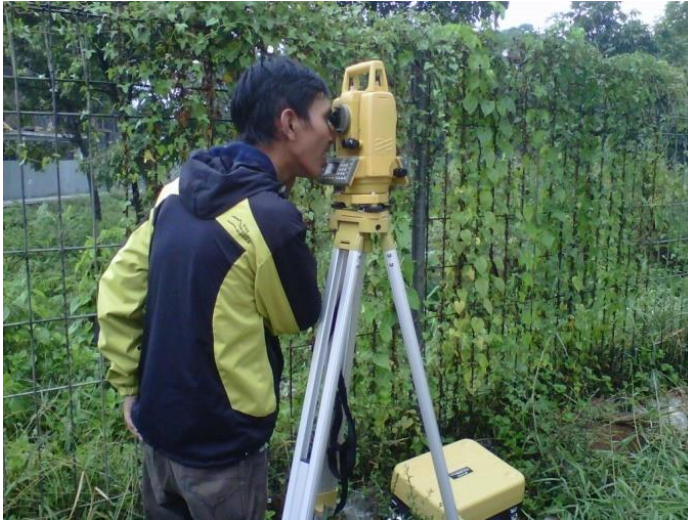
Pengukuran KDH menggunakan ETS (1)
