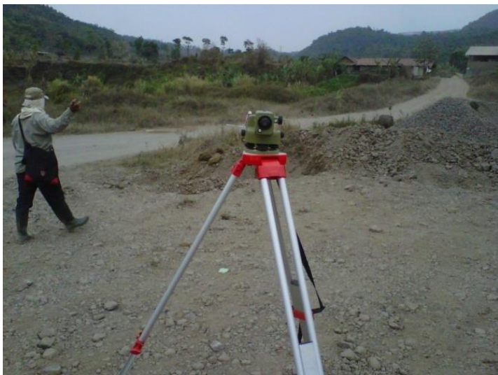
Pekerjaan Pembuatan Jalan (1)
