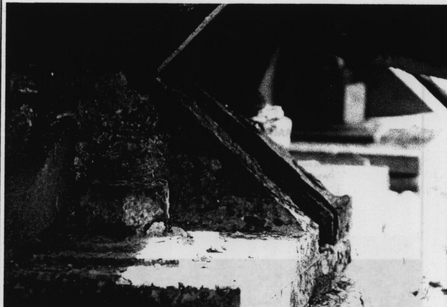
Gambar 4.18 : Perletakan berkarat pada Jembatan Bogor Kerep
