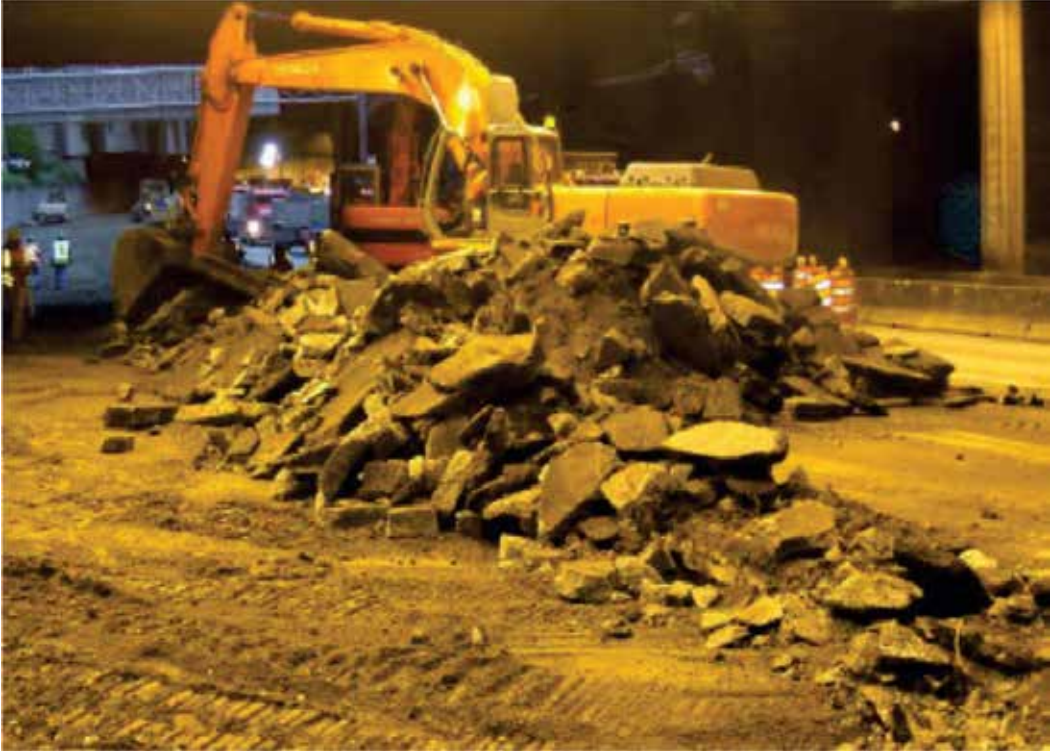
Gambar 3- 3 Pengerukan Badan Perkerasan Jalan
