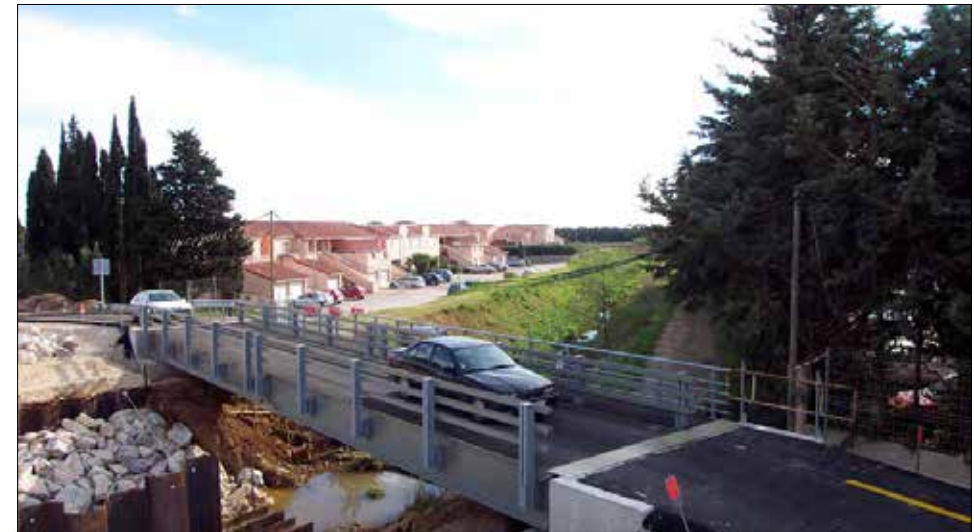
Gambar 7. Unibridge lajur tunggal dek baja (Shepherd; 2005)
