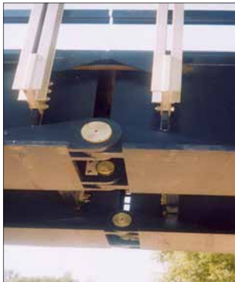
Gambar 10 Bagian hubungan pin setelah disambung
