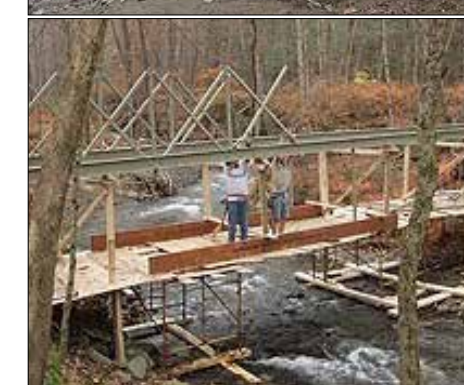
Gambar 35. Proses instalasi jembatan sementara FRP (ettechtonics.com)
