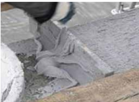
Gambar 2.12. Pekerja untuk merekatkan lantai jembatan diatas upper chord dengan epoksi (Sumber : Fehling, 2007)
