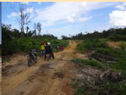
Kondisi Bahu pada Jalan pasir Pantai
