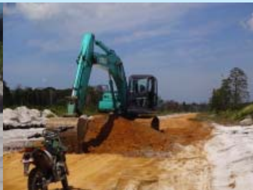
Pekerjaan Timbunan Tanah
