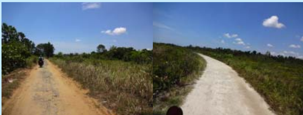
Jalan dengan Lapis Penetrasi
