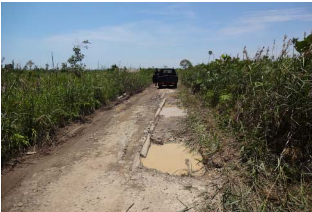
Gambar 4 15 Kondisi badan jalan di daerah cekungan alinemen vertikal pada Ruas Jalan Ceremai - Temajuk, Kec. Paloh, Kabupaten Sambas
