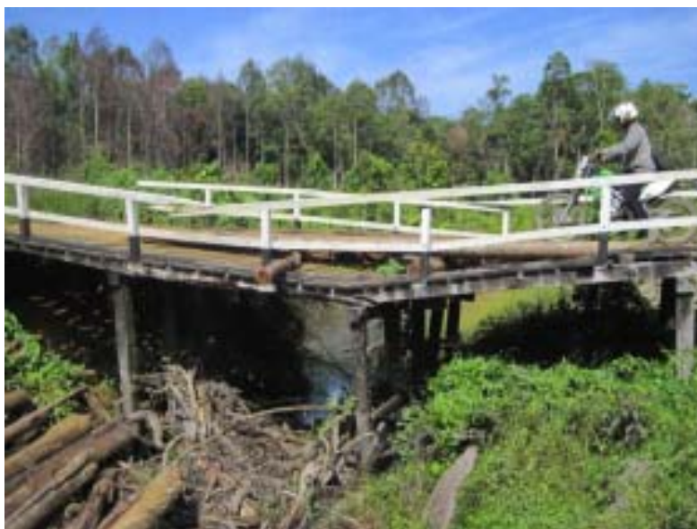
Gambar 4 10 Kerusakan Jembatan Akibat Turunnya Pilar Kayu
