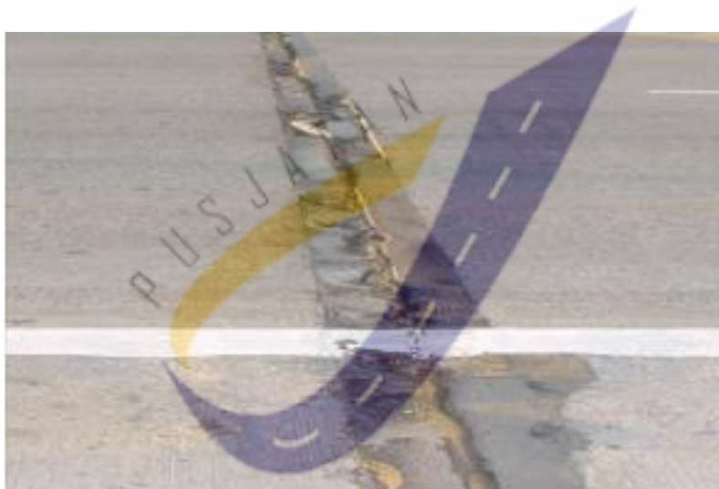
Gambar 58 - Kondisi bahan penutup sambungan muai
