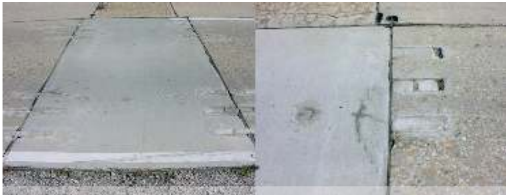
Gambar 57b - Kerusakan pada slot dowel
