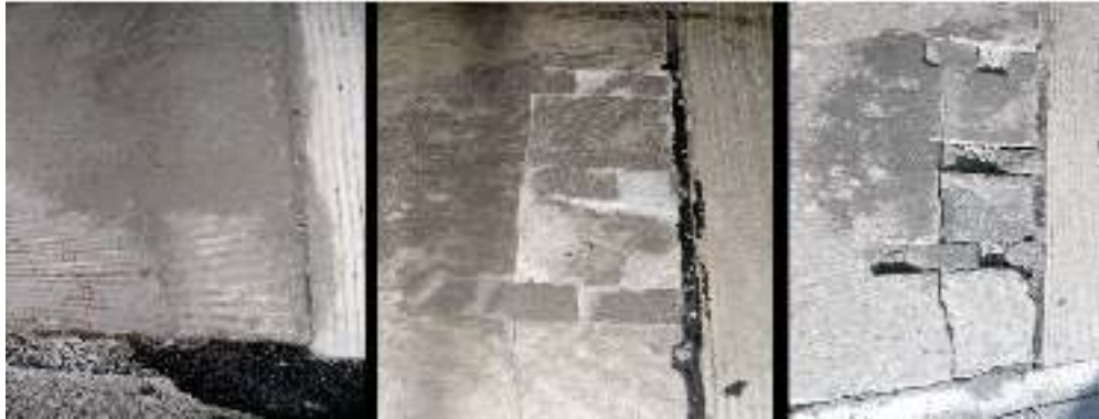
Gambar 57a - Kerusakan slot dowel pada sambungan pracetak
