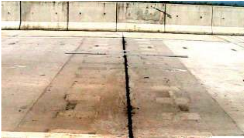
Gambar 35 - Tipikal retak pada Joint panel
