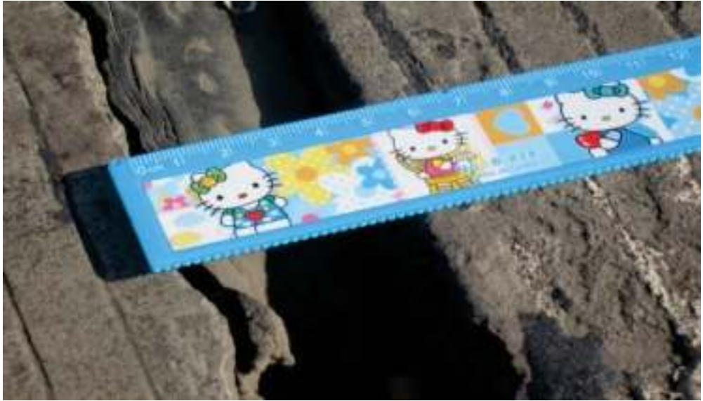
Gambar 48 - Lebar bukaan sambungan muai
