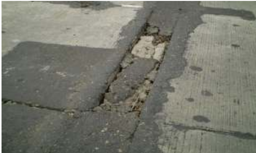
Gambar 29b - Kerusakan sambungan pada perkerasan M4
