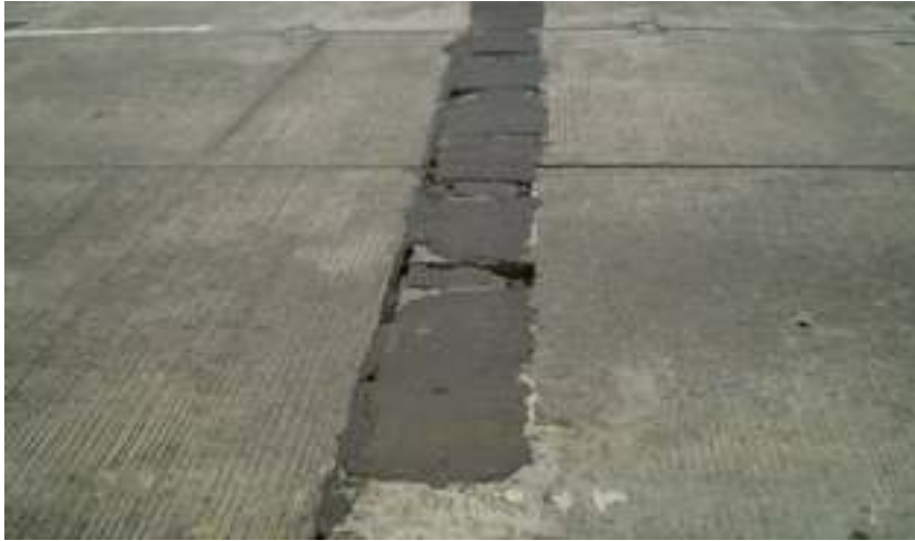
Gambar 30b -Kerusakan sambungan pada perkerasan M3
