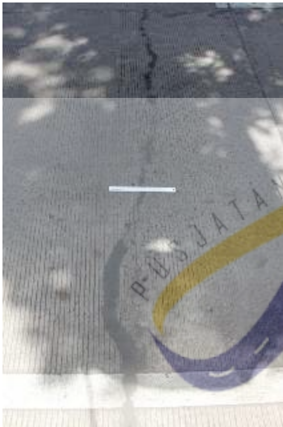
Gambar 60 - Tipikal kondisi celah retak melintang pada jalan beton Cikutra
