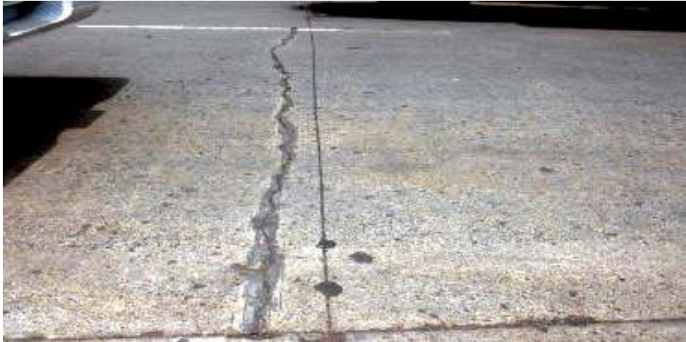
Gambar 61 - Retak melintang dekat ke tepi sambungan
