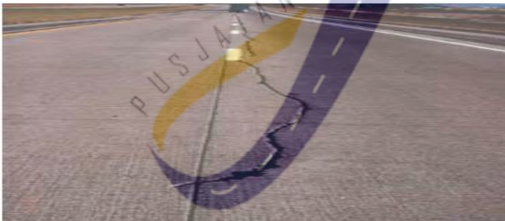
Gambar 19 - Retak memanjang dekat ke tengah
