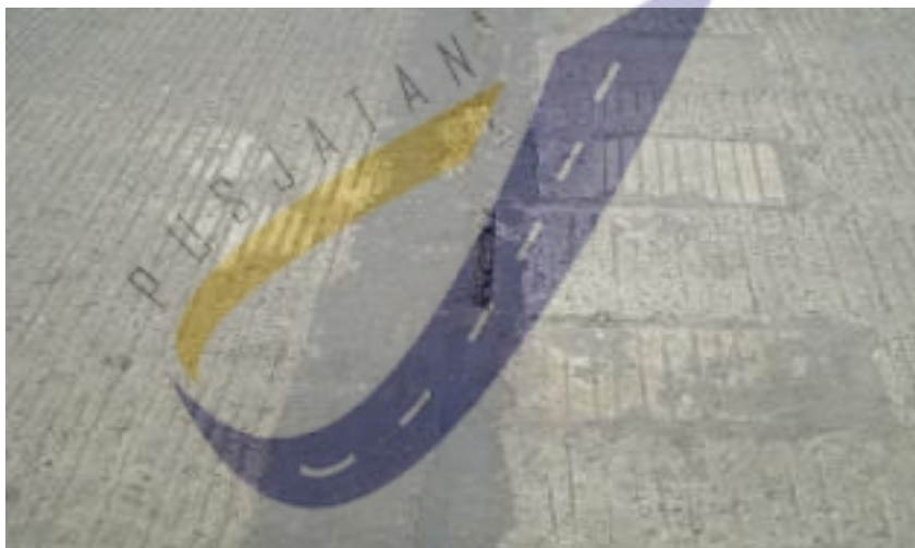
Gambar 30a - Kerusakan sambungan pada perkerasan M3
