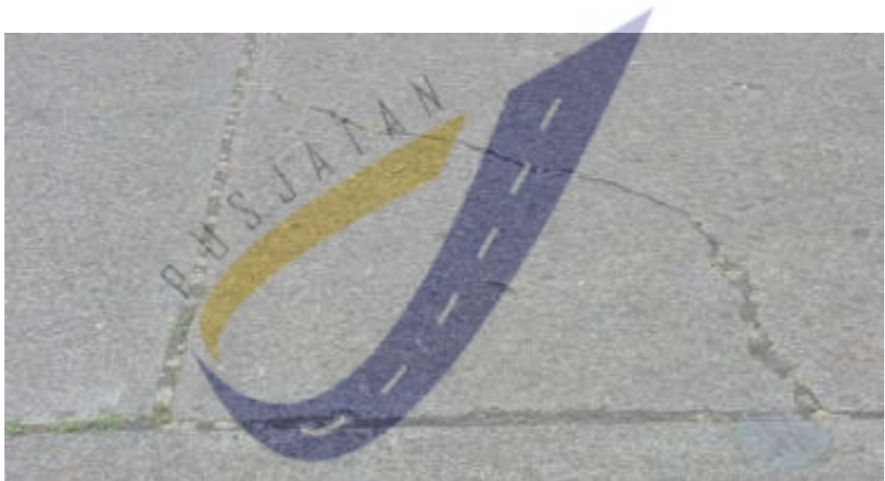
Gambar 21 - Retak sudut
