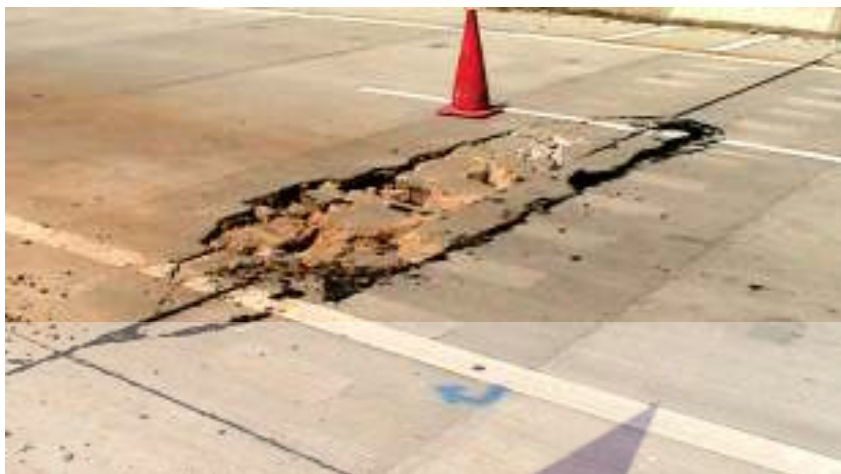
Gambar 36 - Tipikal retak pada Joint panel
