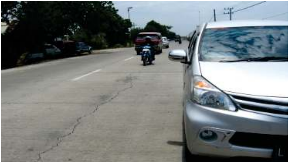
Gambar 68 - Retak memanjang baru sepanjang 6 – 8 panel
