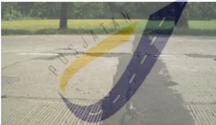
Gambar 31a - Kerusakan sambungan pada perkerasan M1 dowel 1 slot
