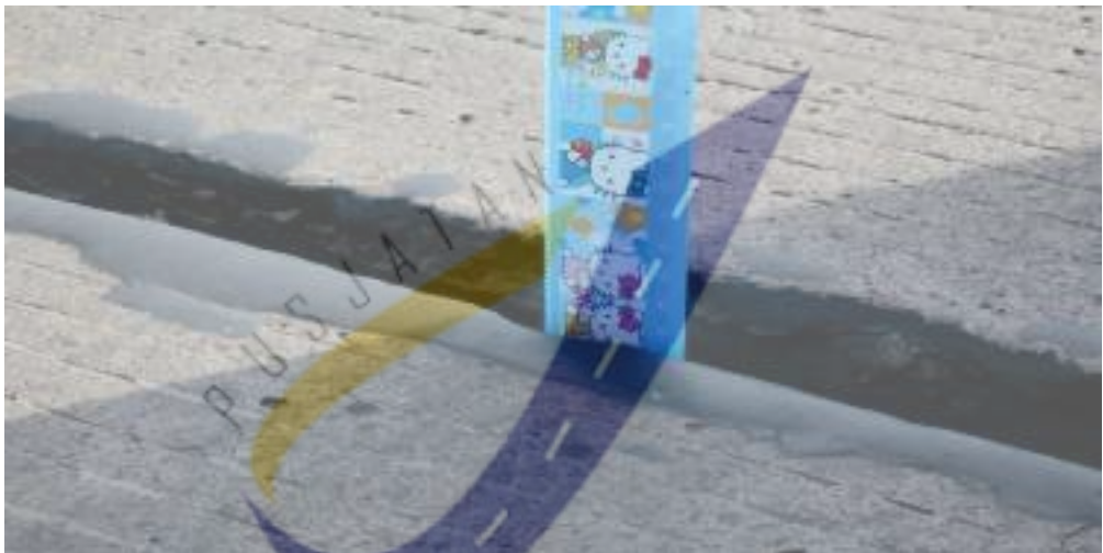
Gambar 49 - Faulting pada sambungan muai
