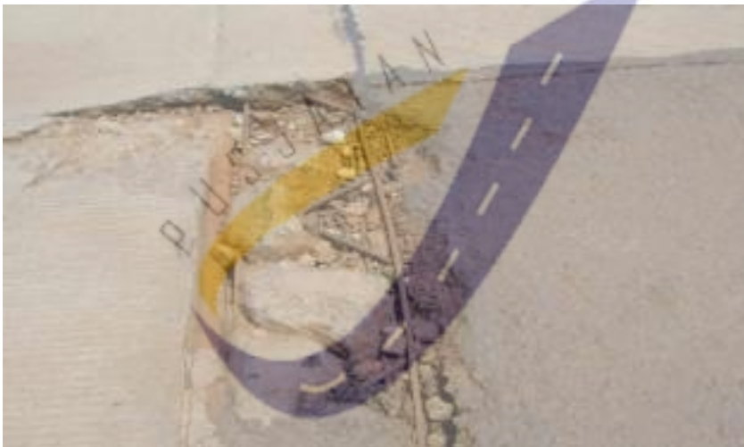
Gambar 41b - Detail kerusakan pada tepi joint panel
