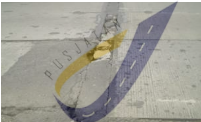
Gambar 29a - Kerusakan sambungan pada perkerasan M4
