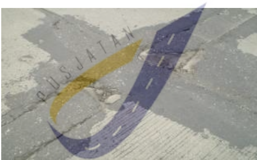
Gambar 28b - Kerusakan sambungan pada M5
