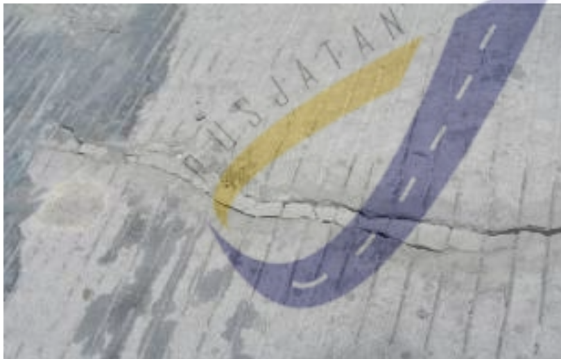
Gambar 67 - Kondisi retak setelah diperbaiki
