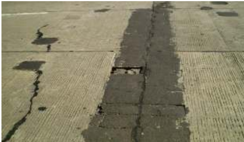
Gambar 31b - Kerusakan sambungan pada perkerasan M1 dengan dowel 2 slot
