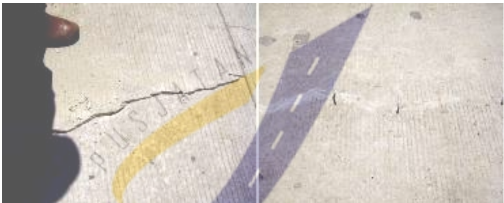
Gambar 65 - Celah retakan yang telah diperlebar dan diberi bahan pengisi
