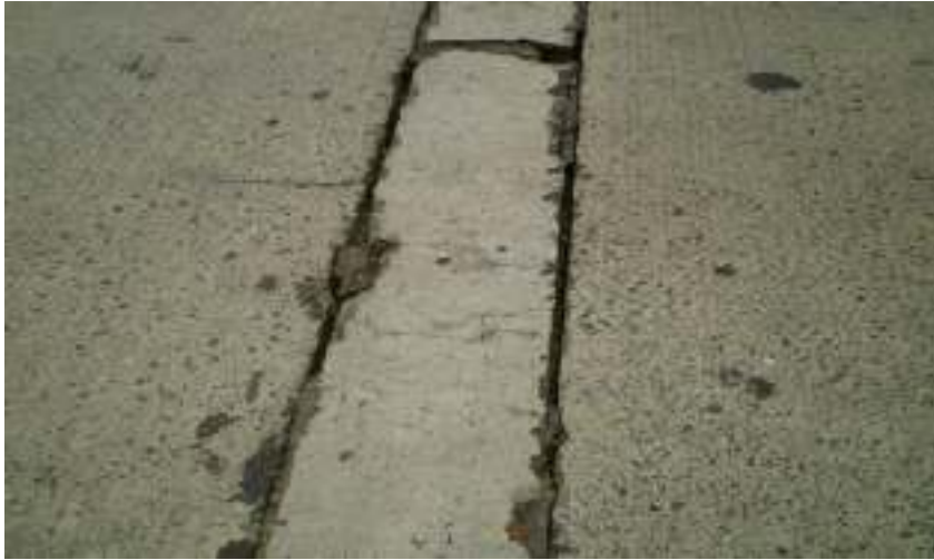
Gambar 28a - Kerusakan pada sambungan M5
