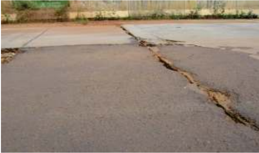
Gambar 41a - Joint panel yang telah diperbaiki dengan Inverted T
