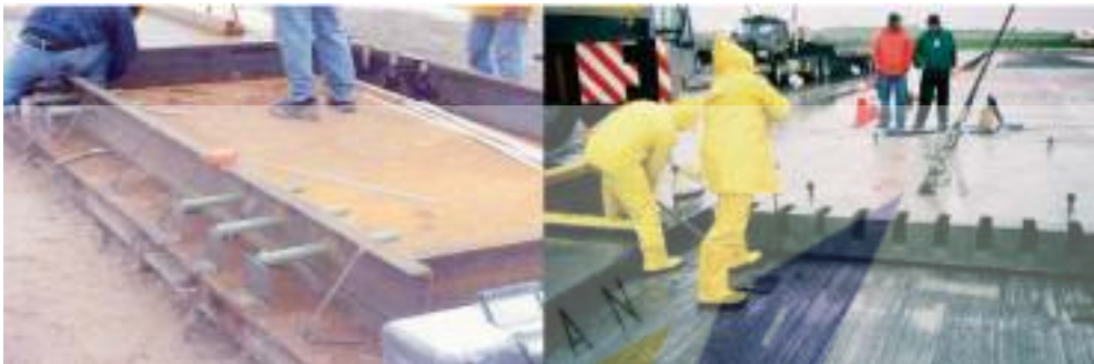
Gambar 9 - Sistem sambungan pada perkerasan pracetak (tanpa tegangan)
