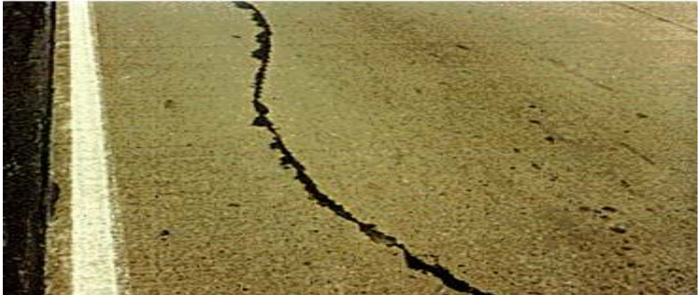
Gambar 20 - Retak memanjang dekat ke tepi
