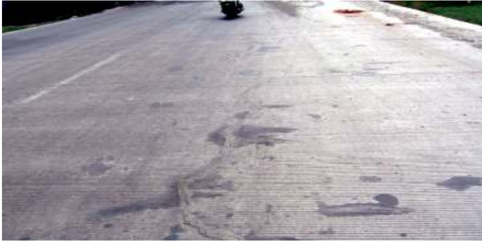
Gambar 66 - Retak memanjang yang telah selesai diperbaiki
