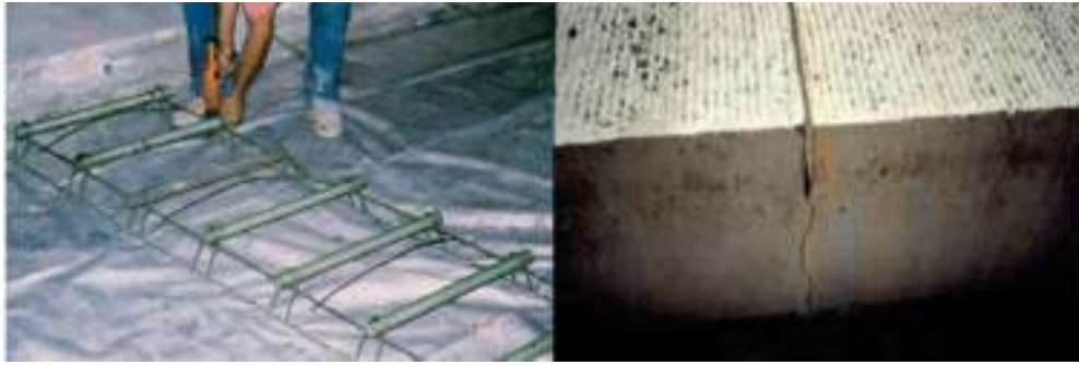
Gambar 8 - Sistem sambungan pada perkerasan beton cor di tempat
