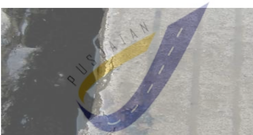
Gambar 51 - Genangan air di dalam sambungan
