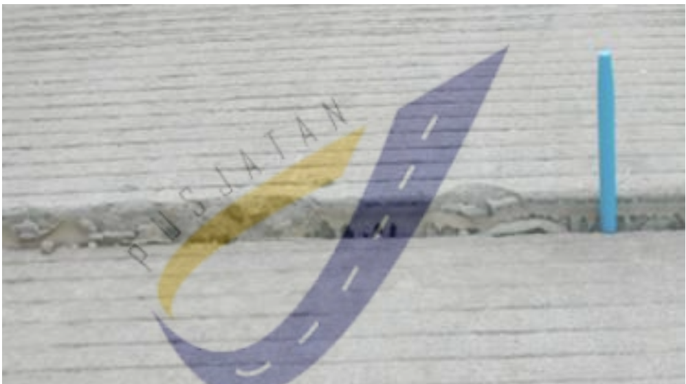
Gambar 14 - Faulting pada sambungan melintang
