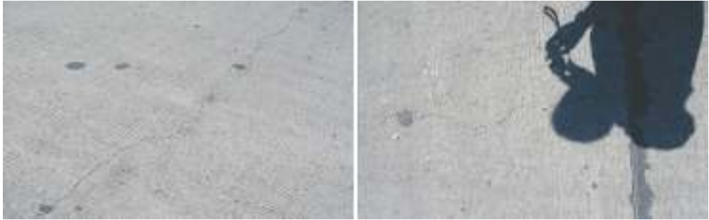
Gambar 64. Celah retak memanjang
