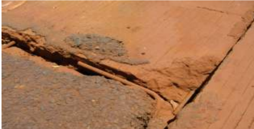
Gambar 41c - Detail kerusakan pada tepi joint panel
