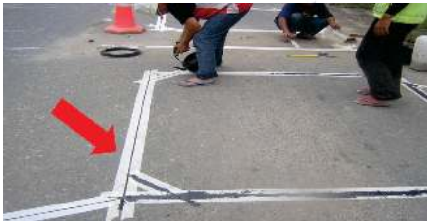
Gambar 3 - Loop Yang Telah Dipasang Di Lajur Jalan
