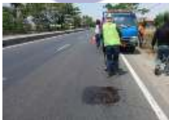
a. Pembentukan dan pemasangan lapis perekat
