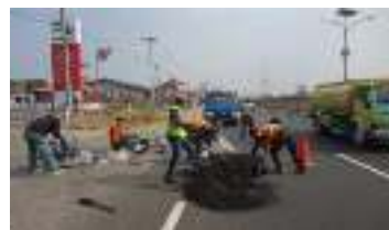
b. Pemasangan lapis perata dengan TCMA-PH2
