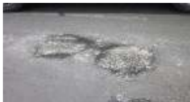
c. Hasil penutupan lubang dengan TCMA-PH3
