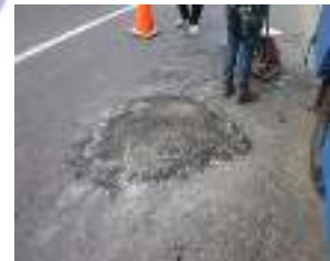
d. Hasil penutupan lubang dengan TCMA-PH3
