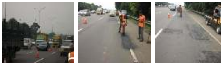
Gambar 3-3. Uji coba bahan tambalan dengan di Tol Jagorawi Arah Ciawi/Bogor (Km 7+900)
