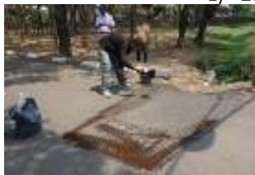
a. Pembersihan dan pemasangan lapis perata
