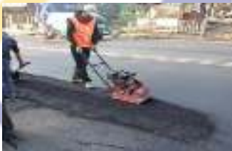
c. Pemasangan lapis perata dan pemadatan TCMA-3PH3
