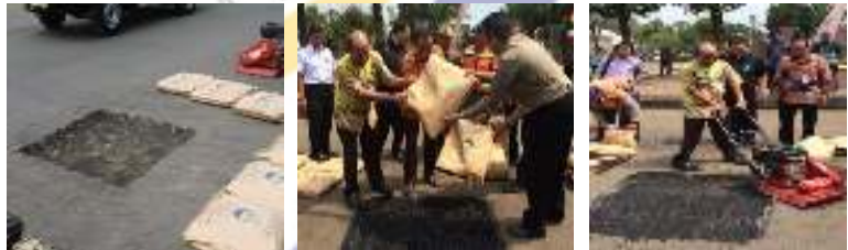
Gambar 3-6. Aplikasi bahan tambalan dengan di Jalan Kota Pekalongan
