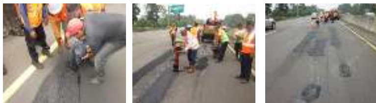
Gambar 3-4. Uji coba bahan tambalan dengan di Tol Jagorawi Arah Cawang (Km 37+000)
