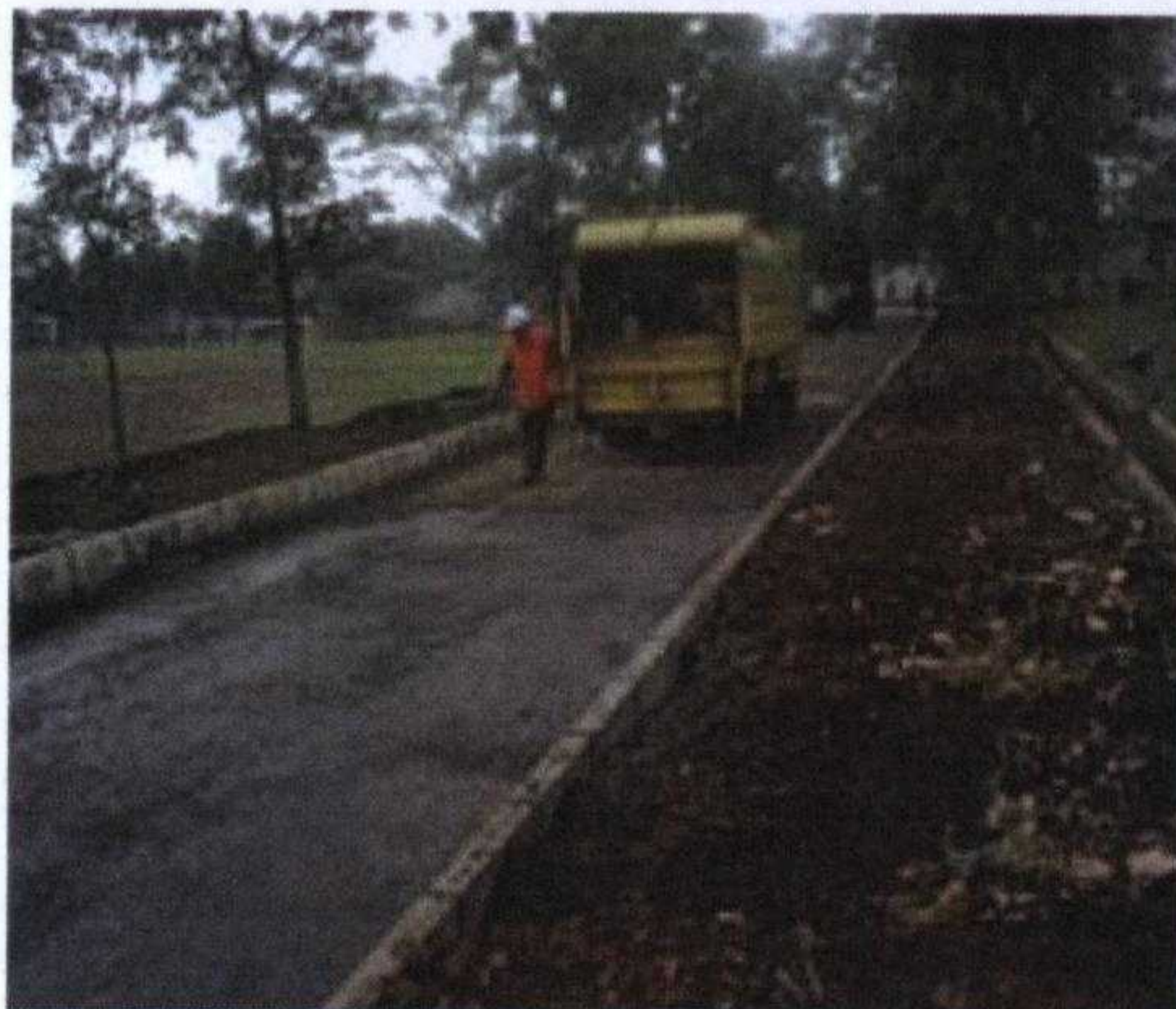
c. Penyemprotan Prime Coat
